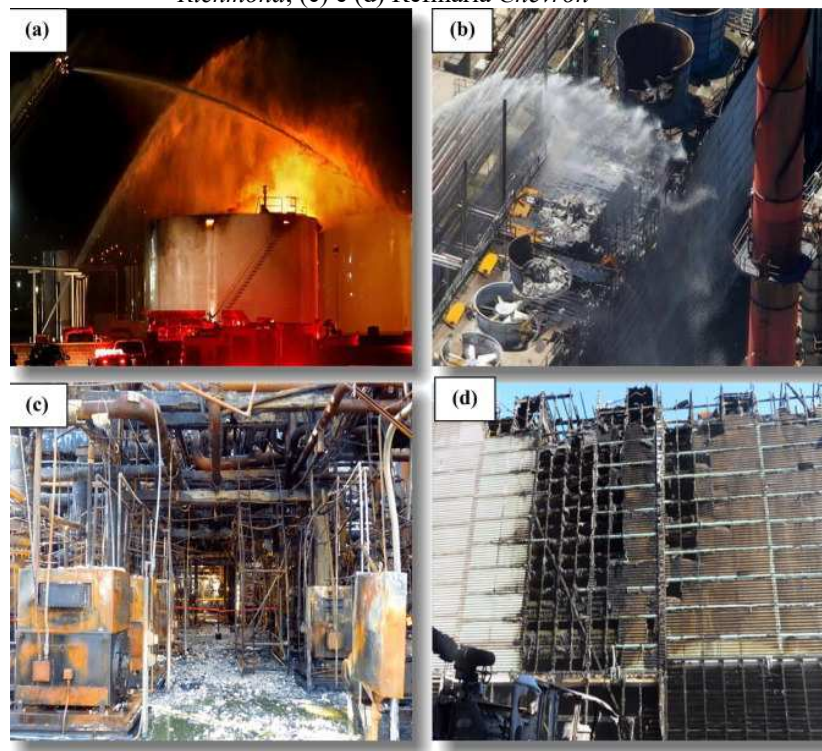
Figura 4- Acidentes em Decorrência de Corrosão em Refinarias. a) Refinaria Golden Eagle , b) Refinaria Richmond , (c) e (d) Refinaria Chevron
