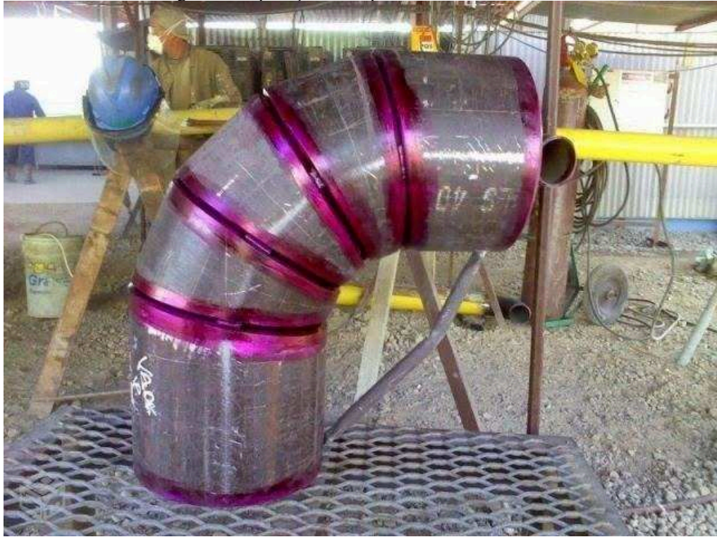
Figura 14- Aplicação de Líquido Penetrante
