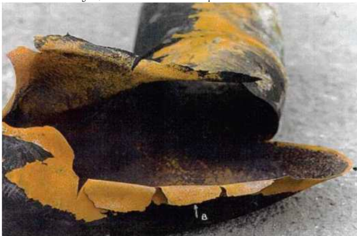
Figura 3- Estado da Refinaria Humber Após Acidente
