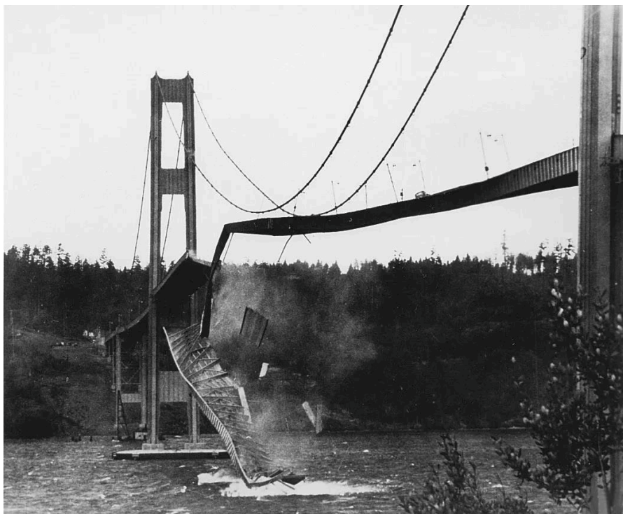
Figura 3 – Colapso da ponte de Tacoma Narrows, 7 de novembro de 1940
