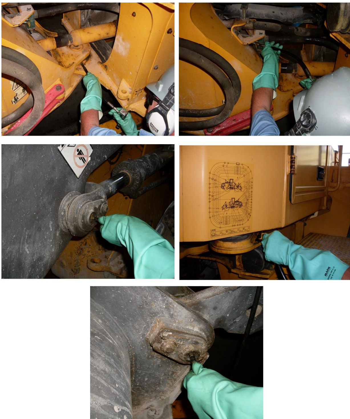
Figura 21 – Operação de inspeção e lubrificação dos pontos da articulação do sistema de elevação e do mancal do giro do centro de uma pá carregadeira
