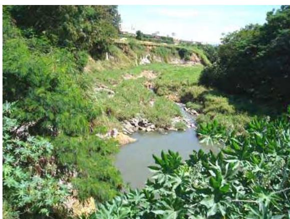
Figura 26 Vista lateral próxima à montante do Córrego Serimbura; auto-regeneração Dez. 2007 - Fonte: A Autora
