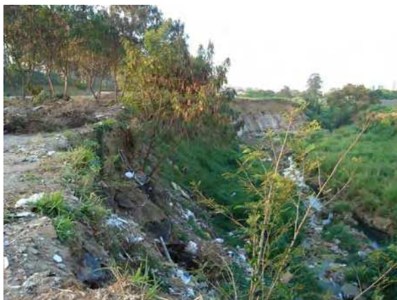
Figura 24 : Vista lateral próxima à montante do Córrego Serimbura de 19 dez. 2006 - Fonte: A Autora
