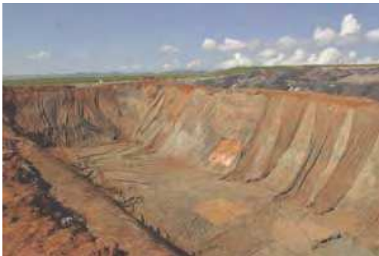
Figura 6. Mantas de PVC para confinamento de resíduo industrial - Aterro ENTERPA. Fonte: http://www.quimica.com.br/revista/qd438/atualidades1.HTML
