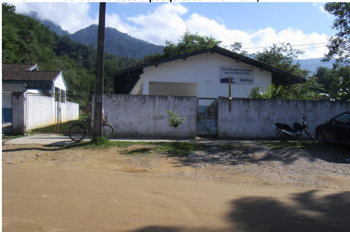
IMAGEM 1: Fachada da escola pesquisada 17/04/2012)
