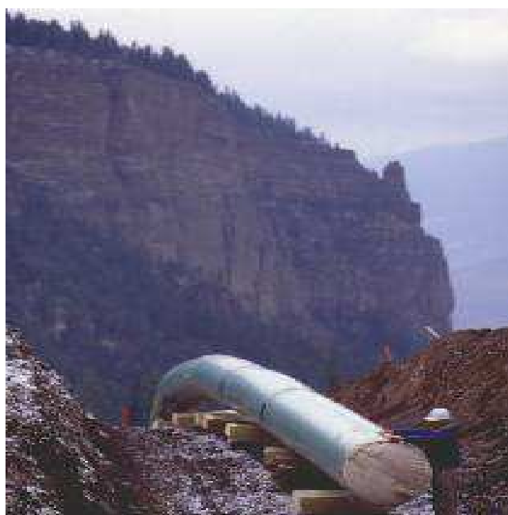
Figura 27 Gasoduto em construção a céu aberto Fonte: NGSA, USA
