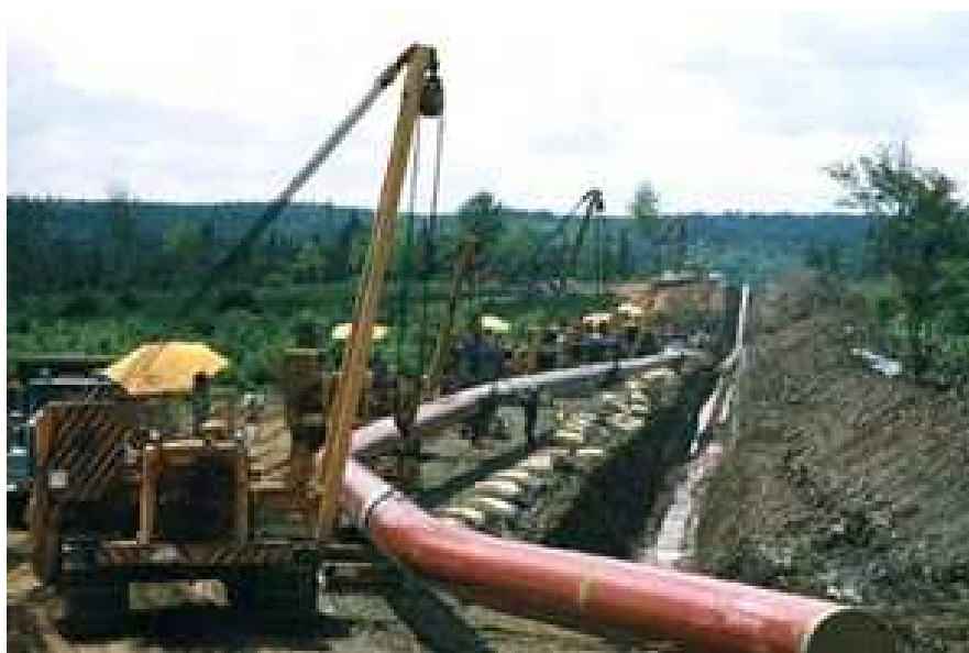
Figura 25 Gasoduto em construção enterrado Fonte: NGSA, USA
