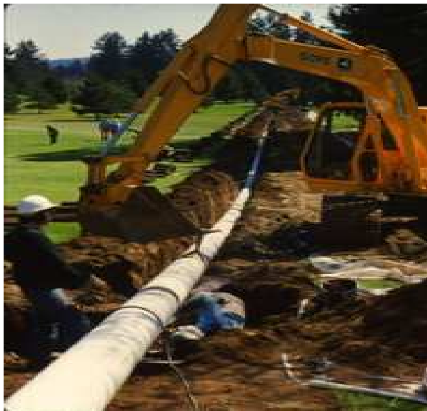
Figura 24 Gasoduto de diâmetro pequeno em construção enterrado Fonte: NGSA, USA
