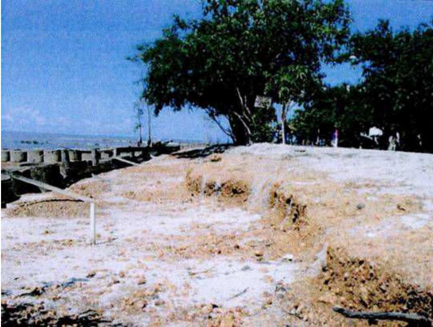
Figura 25 – Avanço da erosão sobre a praia de Beja Fonte: F. M. CRUZ, 2008
