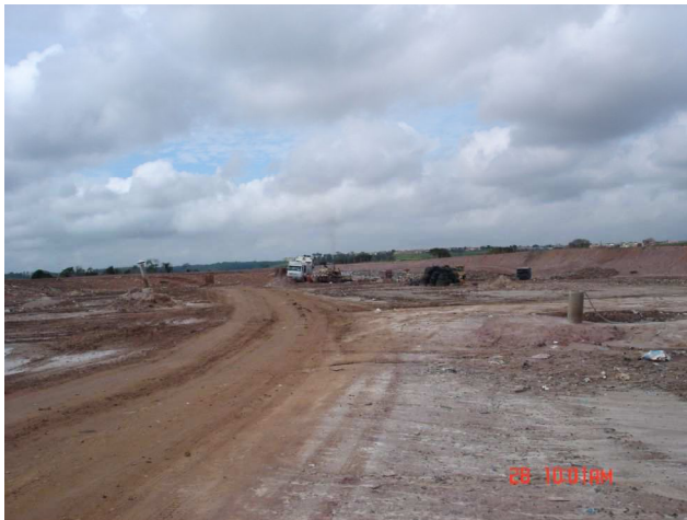
Figura 11: Aterro sanitário da Urbam – São José dos Campos 28/11/2007
