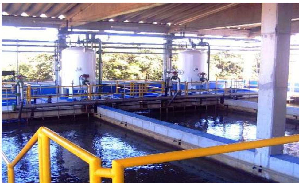
Figura 13 – Vista do sistema flofiltro (Fonte: Sabesp, 2004)
