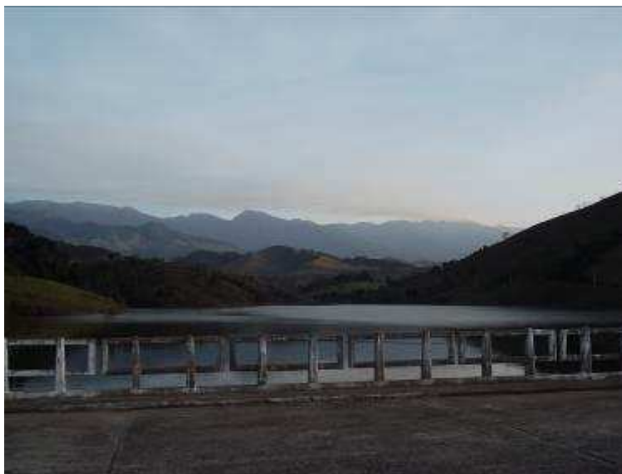
Figura 29 – Ponte sob a represa
