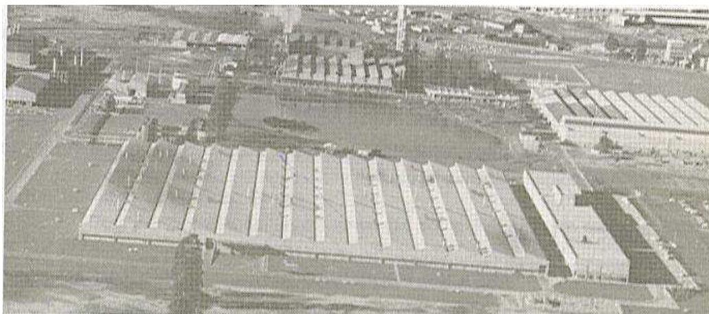
Figura 27 - Ford do Brasil. Em primeiro plano a Fundição II e a Fundição I ao fundo. Fonte: Acervo MISTAU, s.n., s.d.
