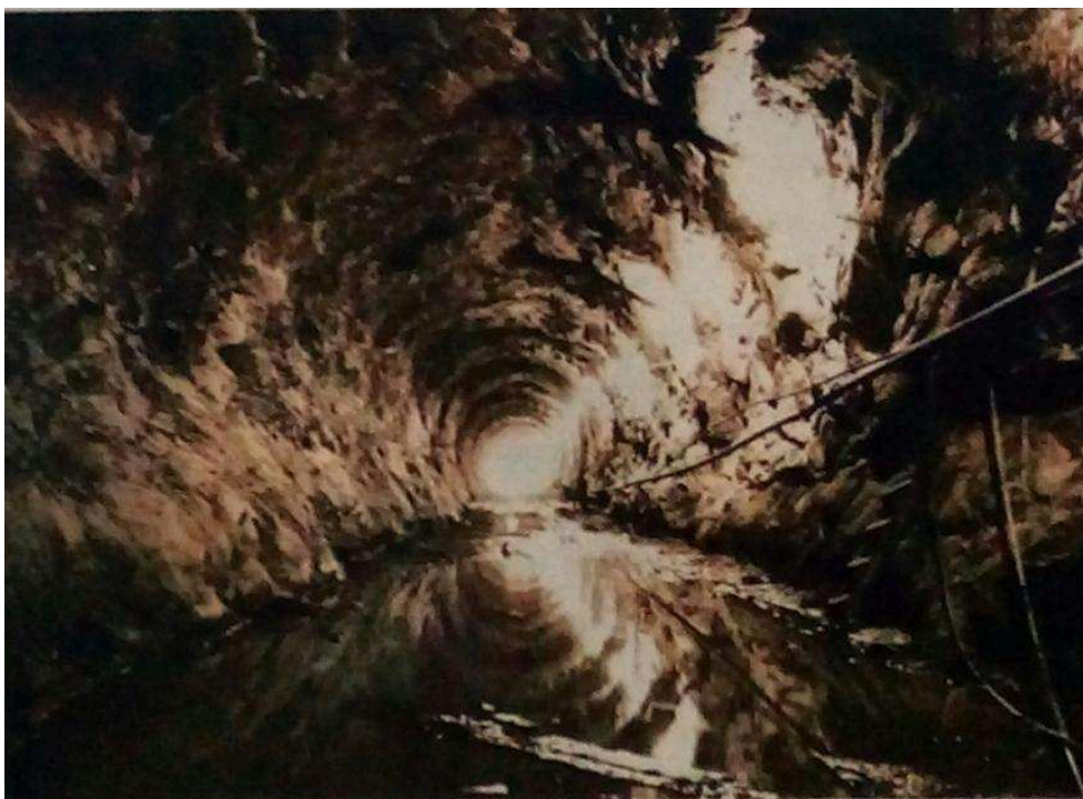
Figura 52 - Túnel de Desvio
