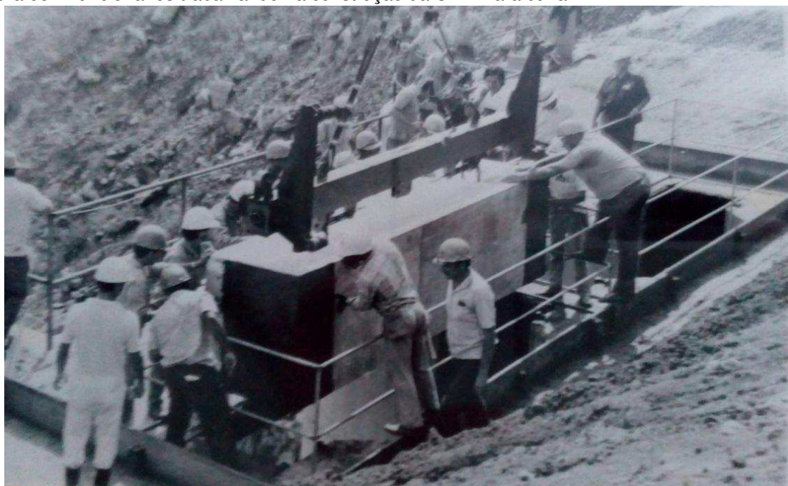
Figura 53 - Funcionários trabalhando na construção da UHE-Paraibuna
