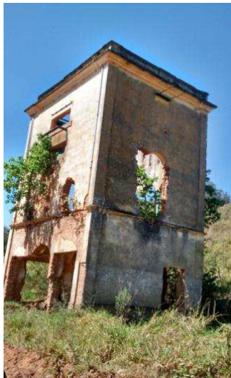
Figura 32 - Imagem do transformador de energia da antiga Usina Felix Guisard
