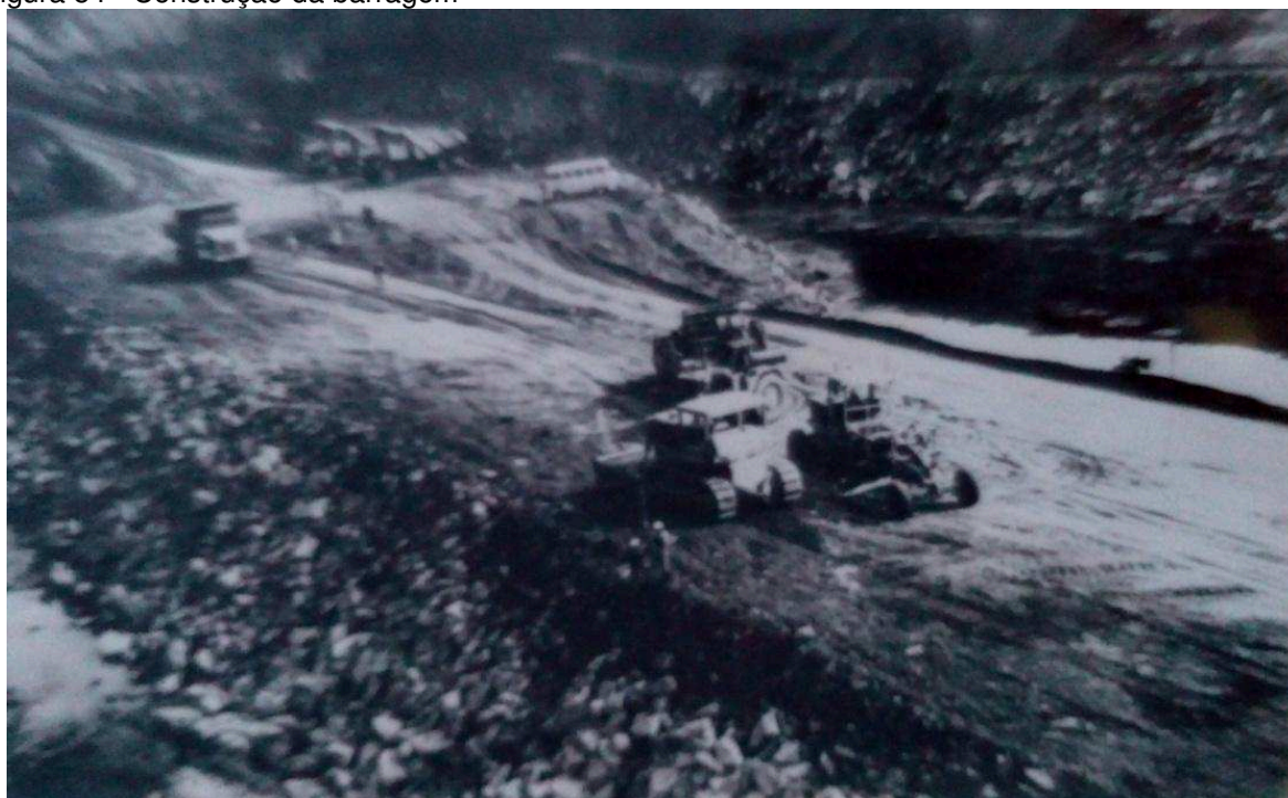
Figura 54 - Construção da barragem
