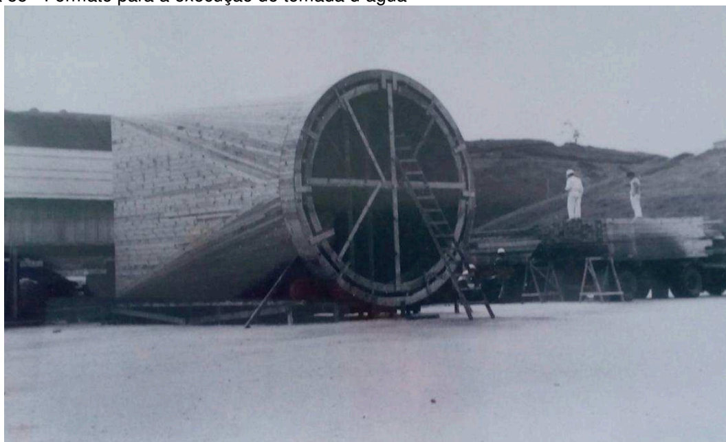
Figura 55 - Formato para a execução de tomada d'água
