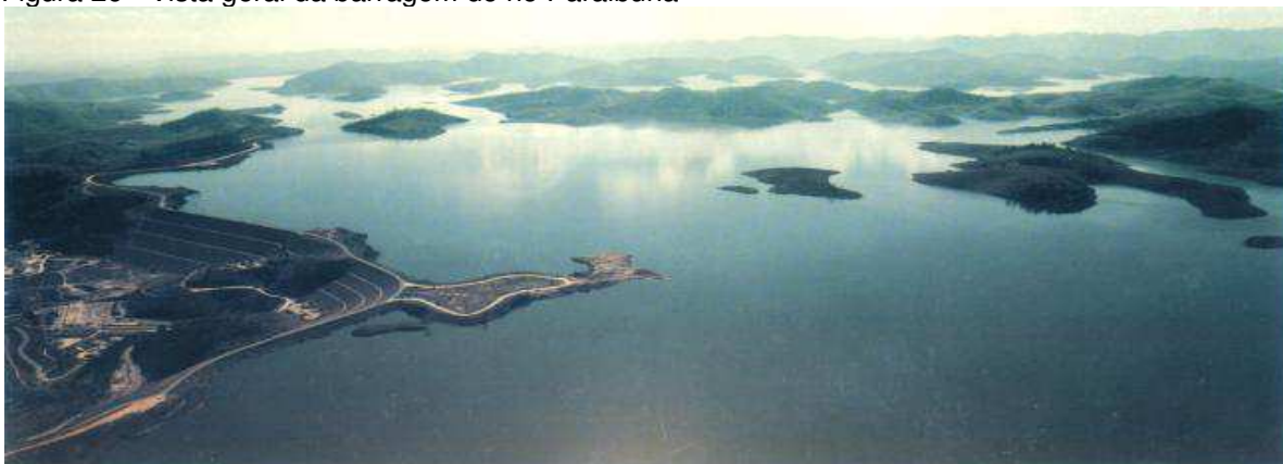
Figura 26 - Vista geral da barragem do rio Paraibuna
