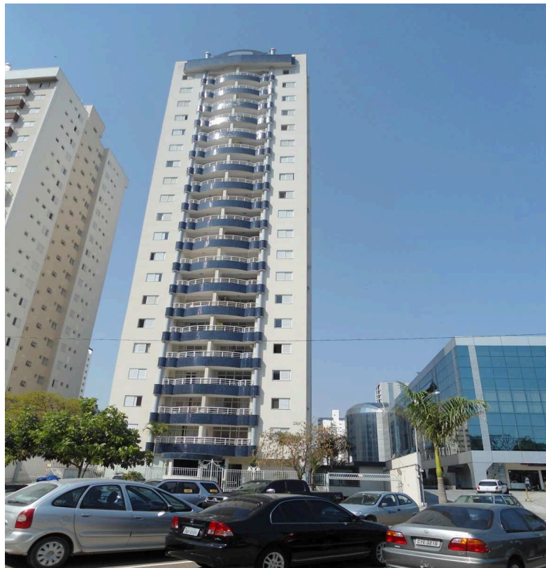
Figura 21 - Edifício Residencial Juquehy Fonte: Autor (2012)
