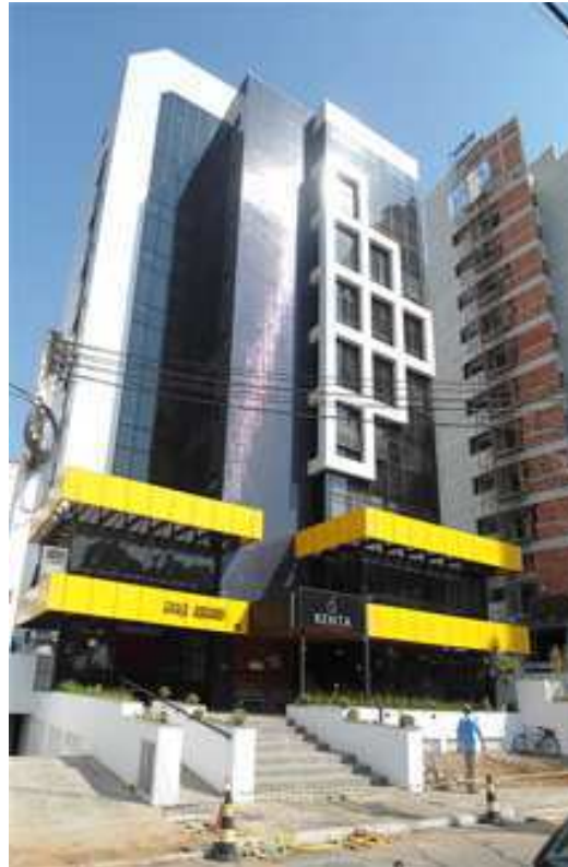
Figura 18 – Edifício Pacífico Sul Fonte: Autor (2012)
