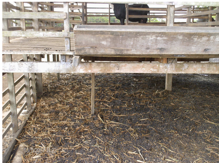
Figura 6 – Altura do Aprisco do chão (1,50m do solo) Fonte: Autor
