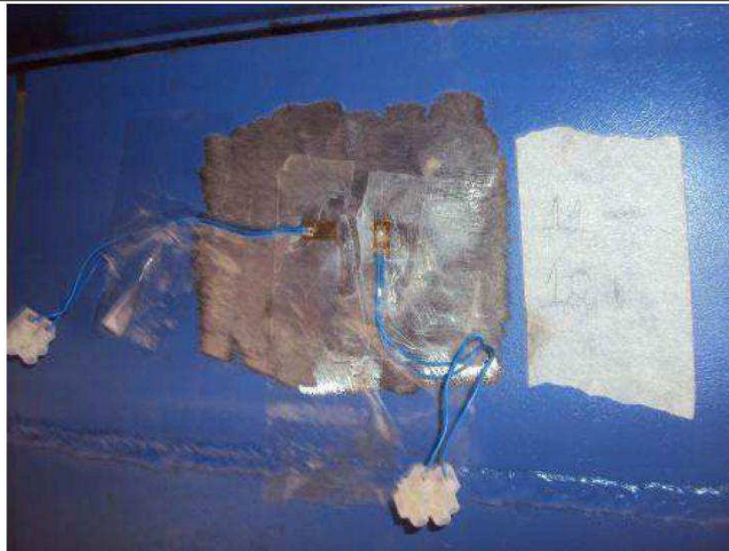
Figura 8 – Detalhe dos strain-gages 11 e 12.
