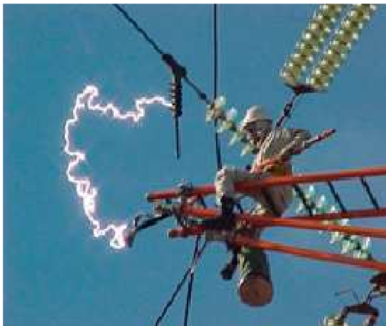
Figura 2 Arco Elétrico Fonte: AWstorm, 2018.
