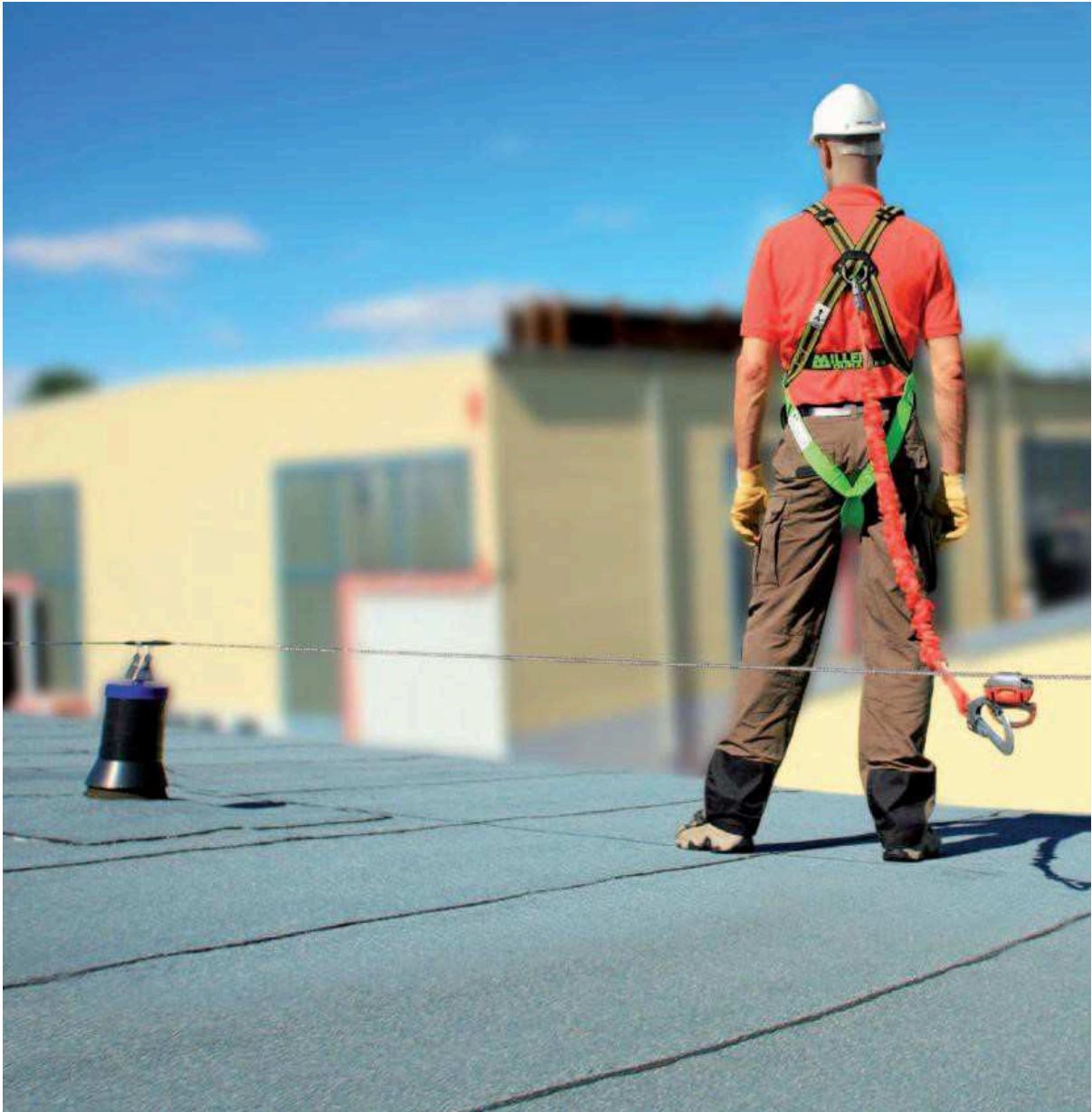
Figura 5: Linha de vida horizontal Fonte: PIRES , 2014.
