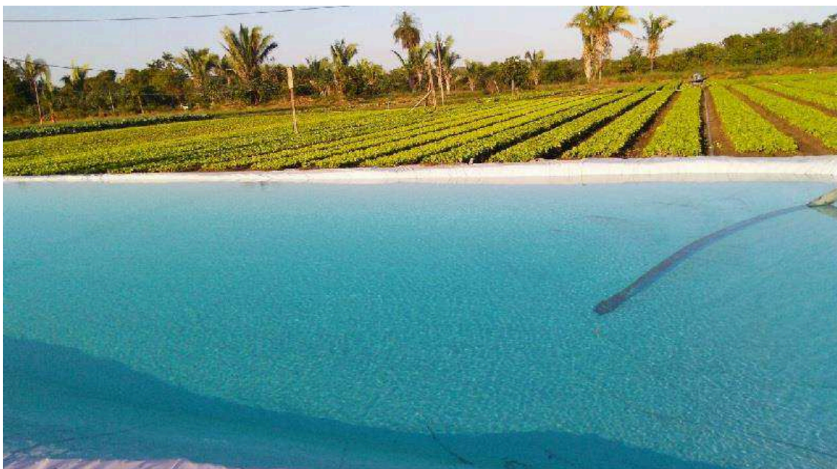
Figura 9 - Reservatório de água bairro Vila Nova
