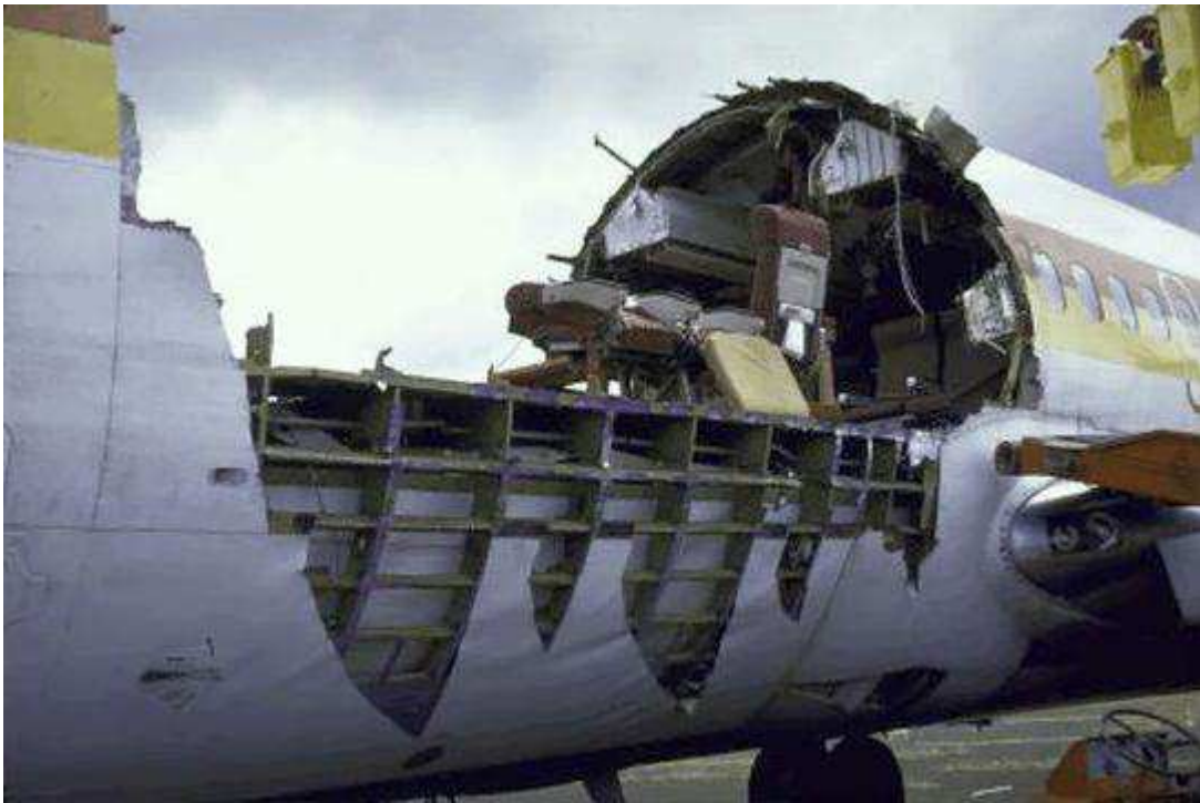
Figura 18 – Aeronave Boeing 737 da Aloha Airlines, após o acidente de descompressão explosiva em voo. Fonte: Internet.
