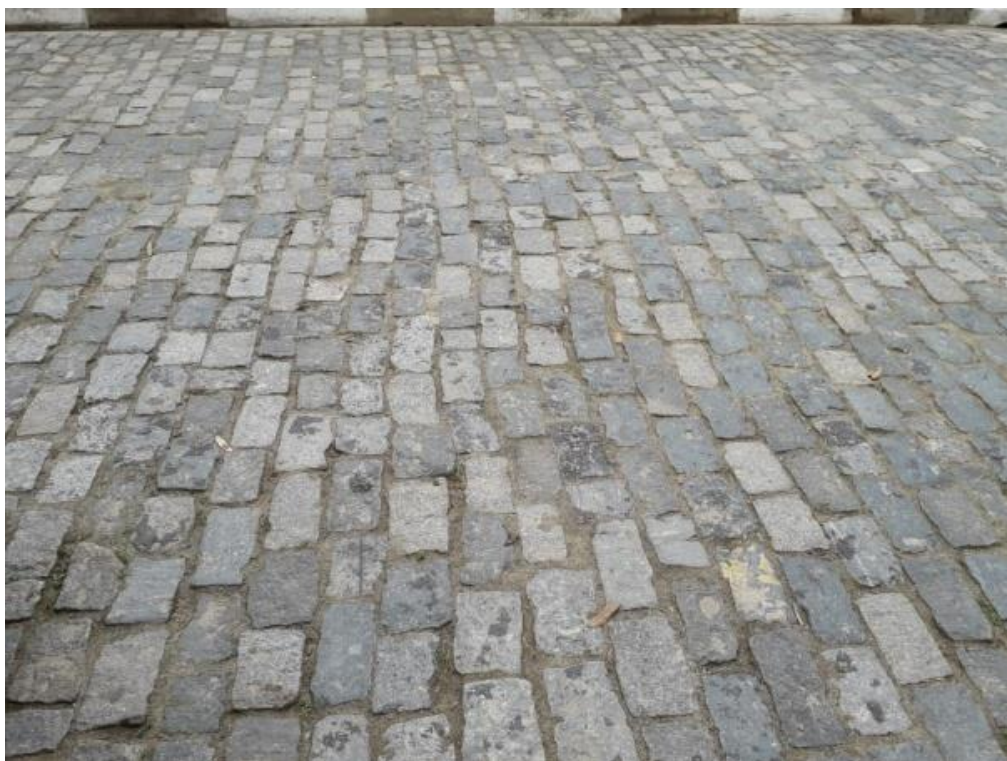
Figura 05 – Pavimentos permeáveis: Paralelepípedos
