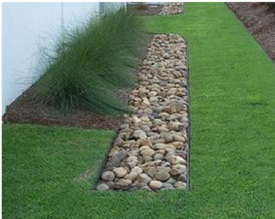
Figura 08 – Trincheiras de infiltração
