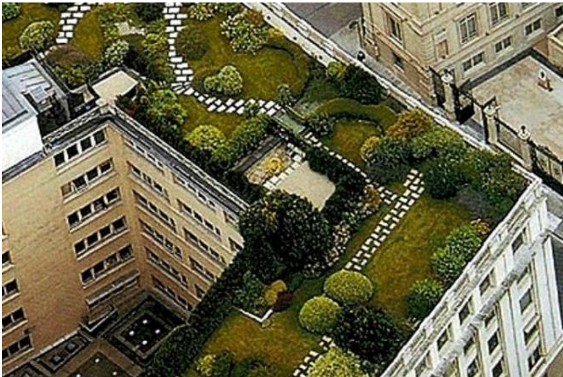
Figura 12 – Telhado verdes em um edifício
