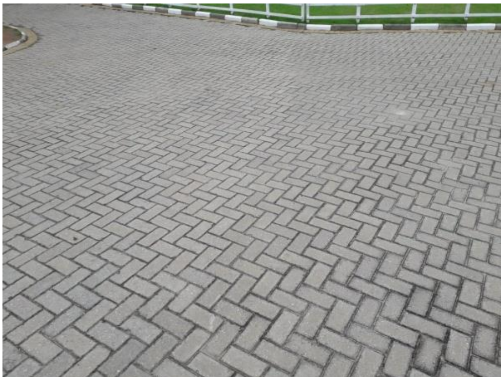
Figura 04 – Pavimentos permeáveis: Piso intertravado
