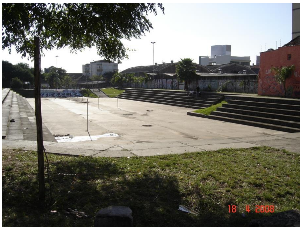
Figura 06 – Reservatórios de Detenção
