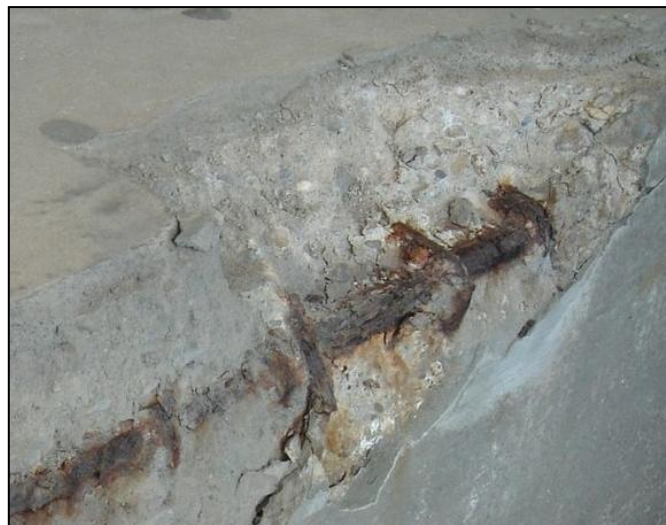
Figura 8 - Carbonatação
