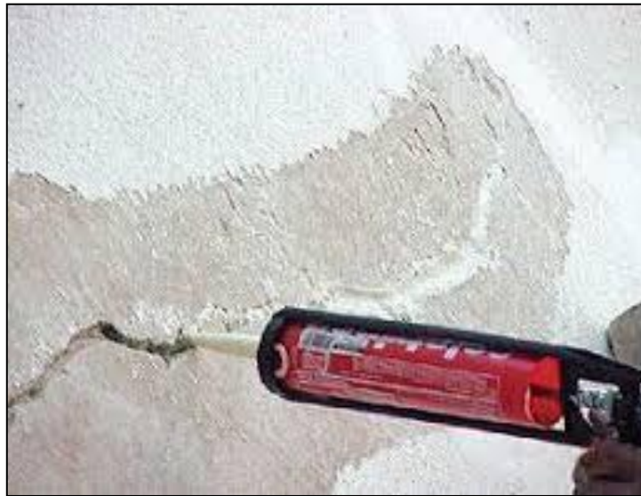
Figura 11 - Selagem de Fissura
