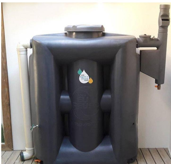
FIGURA 6. Cisterna vertical modular, instalada em uma varanda.
