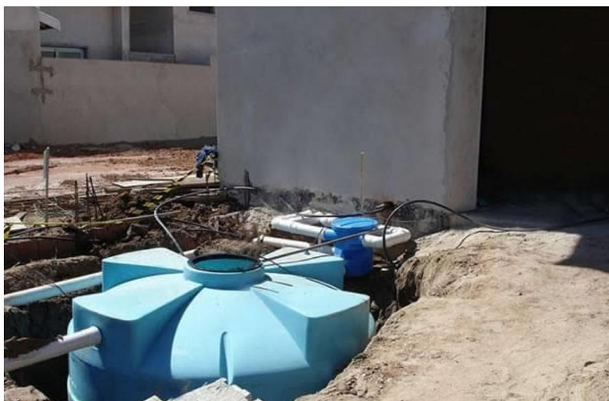
FIGURA 4. Instalação de uma cisterna enterrada de plástico.
