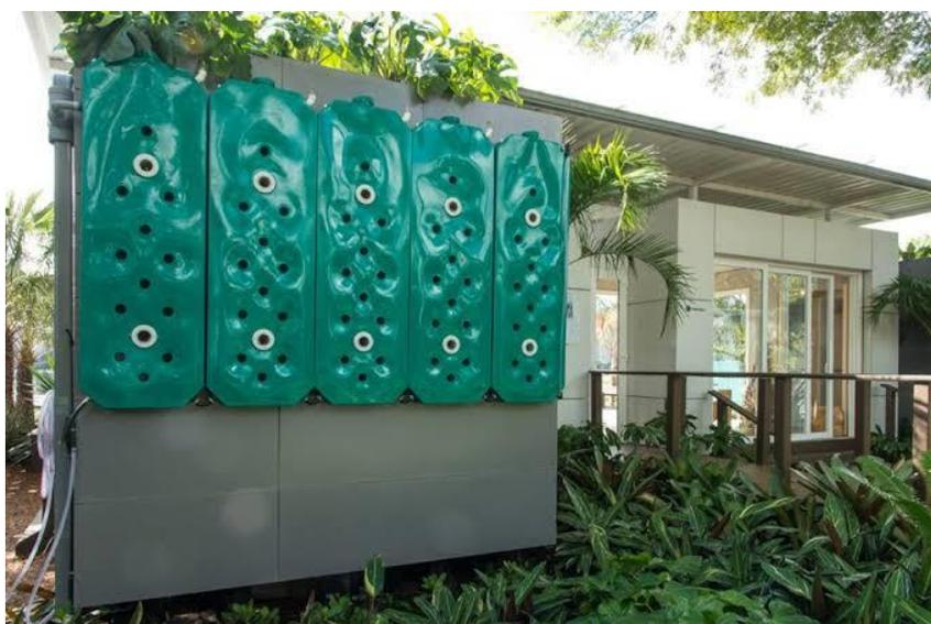
FIGURA 7. Cisterna *Waterbox* instalada no jardim de uma residência.
