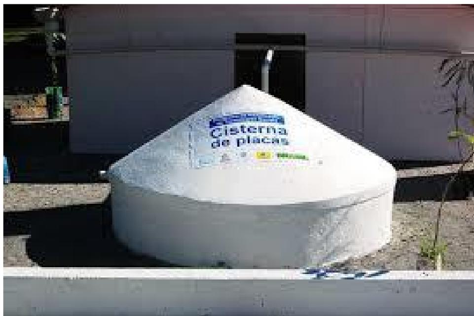
FIGURA 5. Cisterna semienterrada de placas pré-moldadas instalada em uma indústria.
