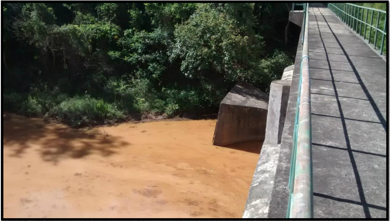
Figura 2. Vista anterior jusante a Barragem do Ribeirão dos Mottas.
