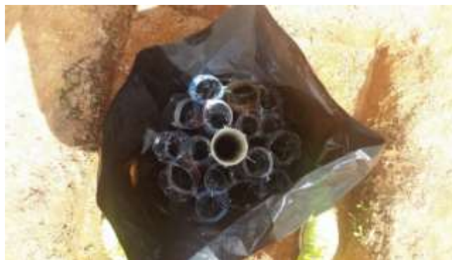
Figura 18: Instalação do sumidouro envolto com saco plástico no solo.
