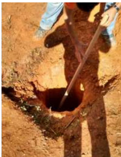
Figura 16: Escavação do buraco para instalação do sumidouro. O mesmo possui diâmetro equivalente a 0,45 cm, com uma profundidade de 1m, conforme dimensionamento.
