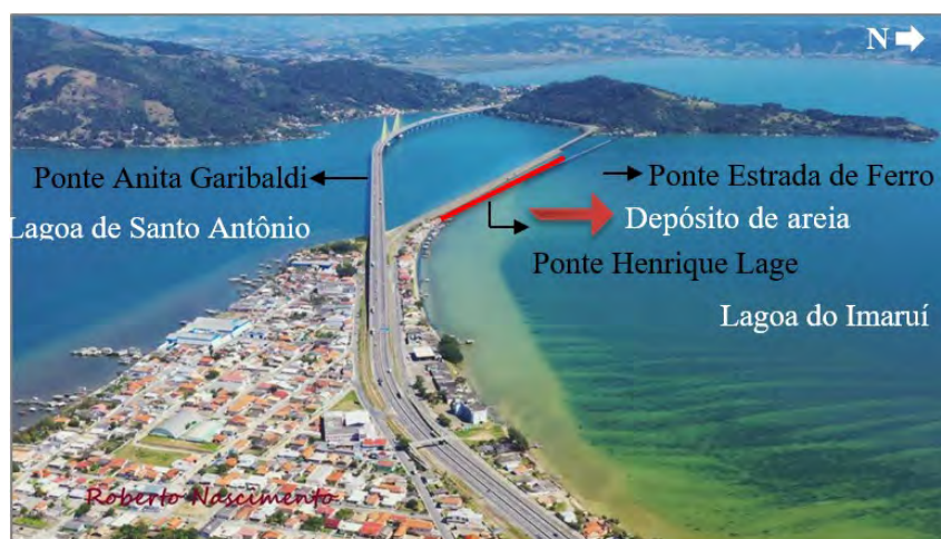
Figura 2 - Foto Pontes sobre o Canal da Laranjeira
