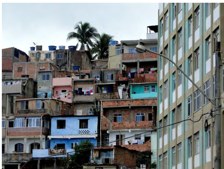
Figura 1 – Construções desiguais, Salvador – Bahia Fonte: Janelize Nascimento Felisbino (2013).
