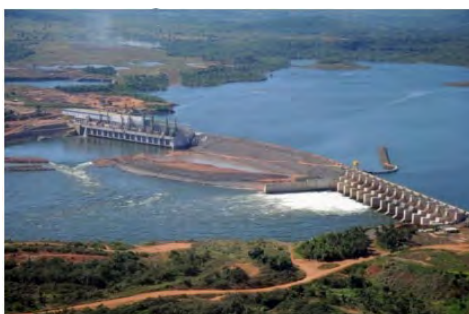
Figura 1- Usina Hidrelétrica de Estreito.
