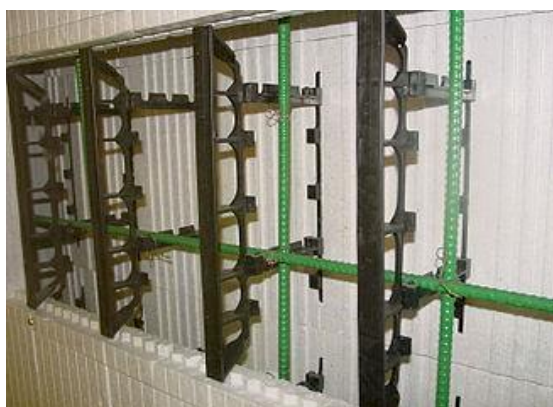
Figura 36 - Detalhe de montagem do sistema Isocret.
