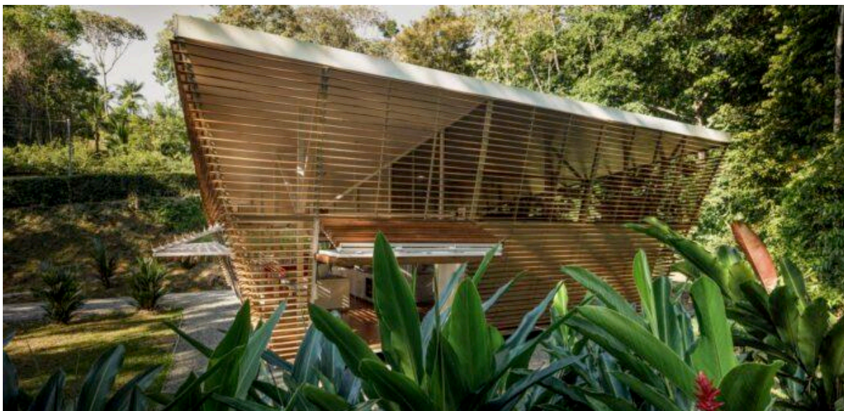
Figura 12 - Fotografia: residência sem impacto.
