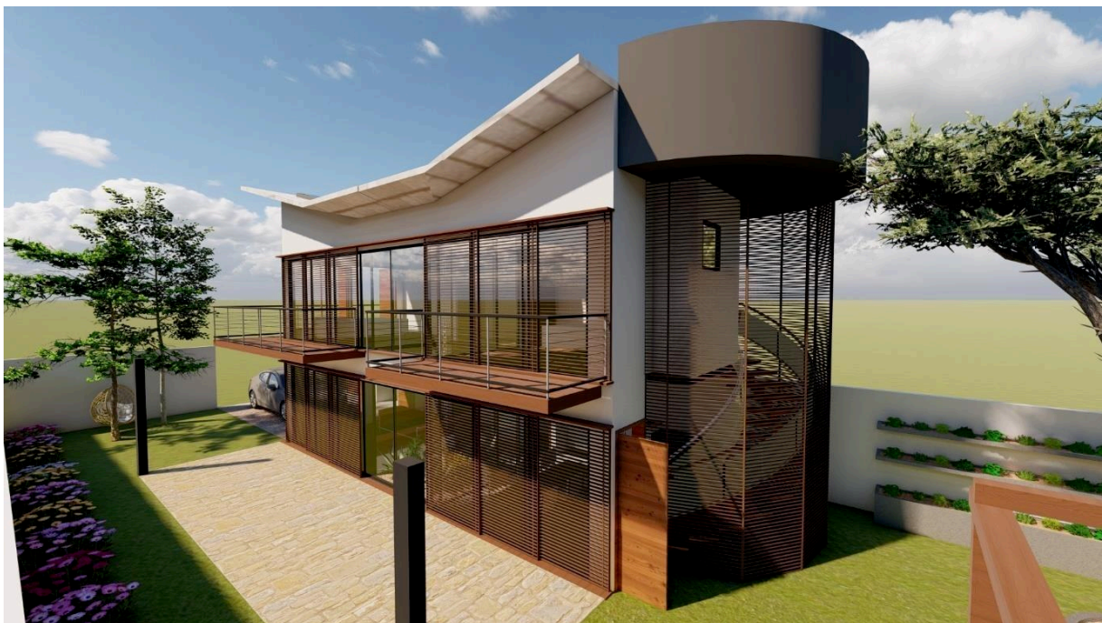
Figura 44 - Renderização da casa eficiente detalhe dos brises da fachada oeste.
