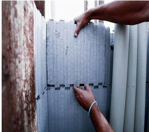
Figura 19 – Detalhe do método de construção.
