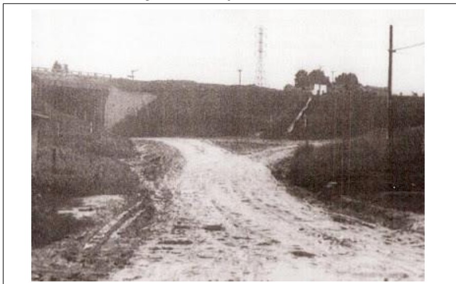
Figura 2: Construção da Av. Brasil (1982)
