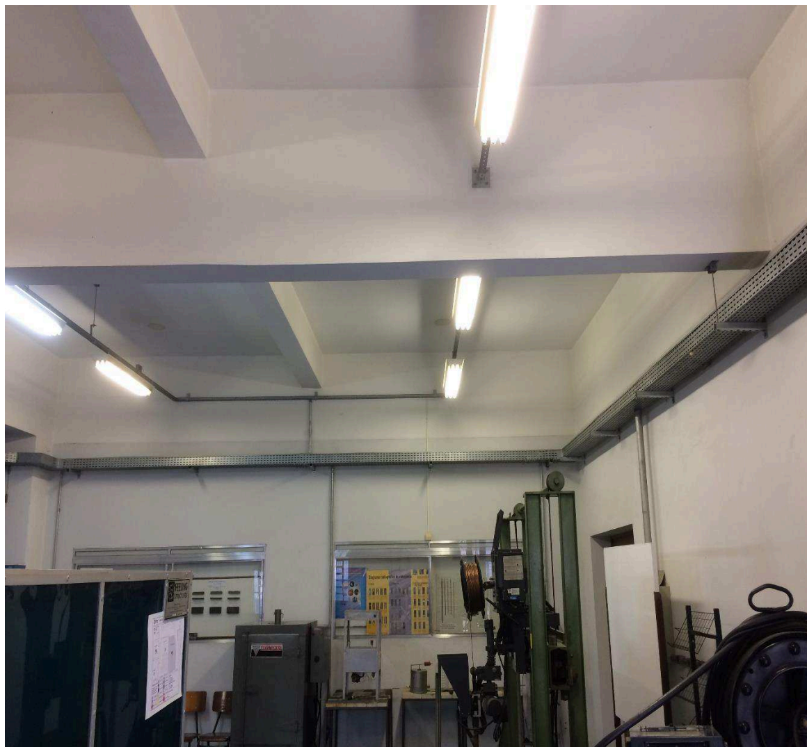
Figura 9 - Seiketsu locais instalação ventiladores
