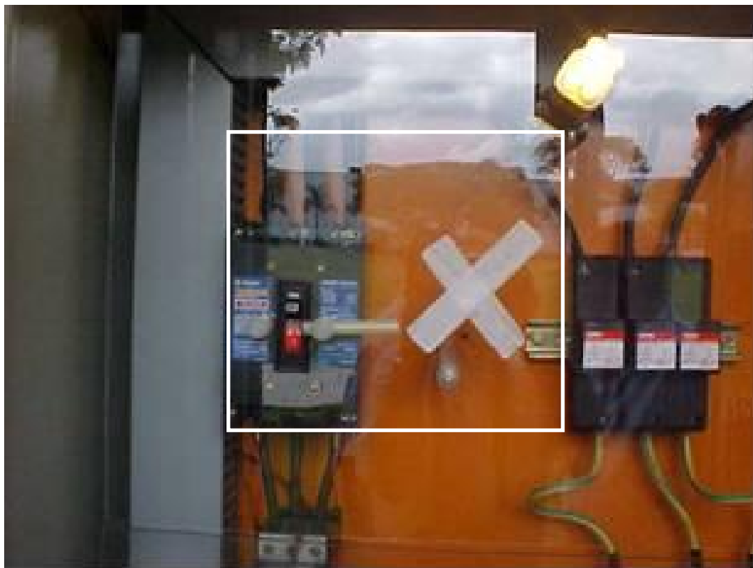
Figura 5 Instalados os dispositivos de travamento e a placa de policarbonato.
