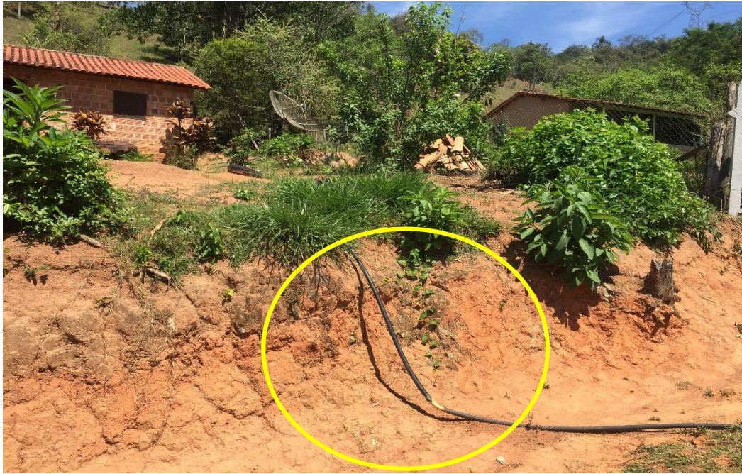
Foto 18: Captação irregular de água Fonte: Yasmin Nogueira Costa (2019)
