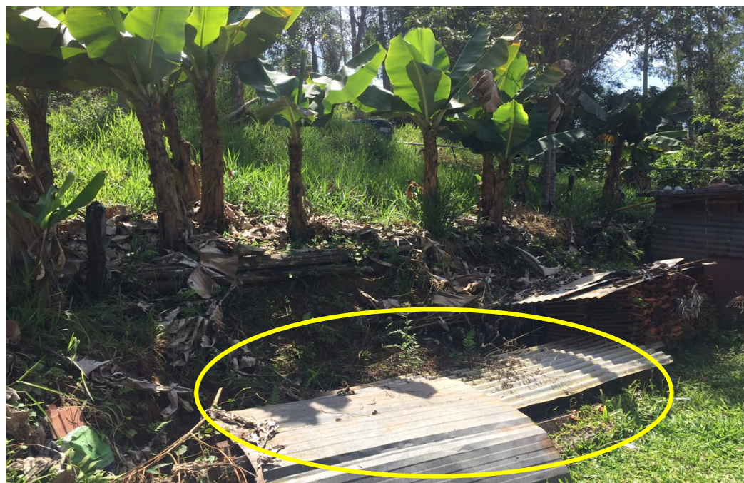
Foto 05: Fossa negra de uma das residências
