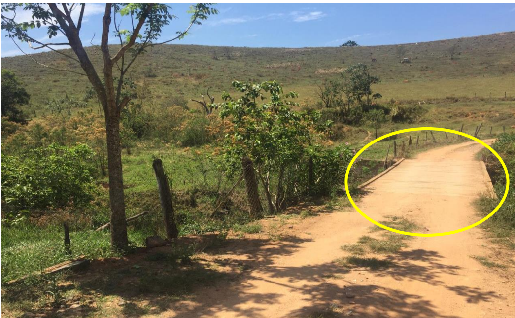
Foto 13: Intervenção irregular em Área de Preservação Permanente (APP)
