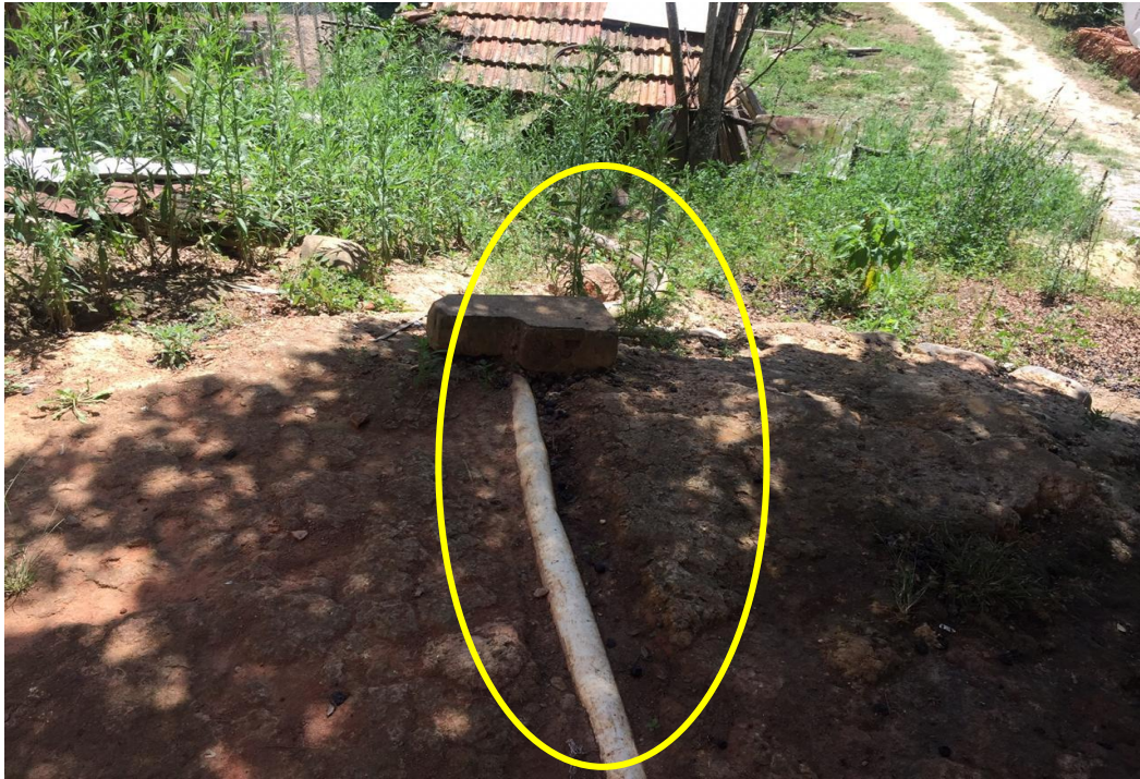
Foto 10: Encanamento de esgoto desembocando no córrego
