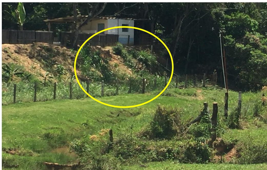
Foto 03: Residência despejando esgoto no leito do córrego
