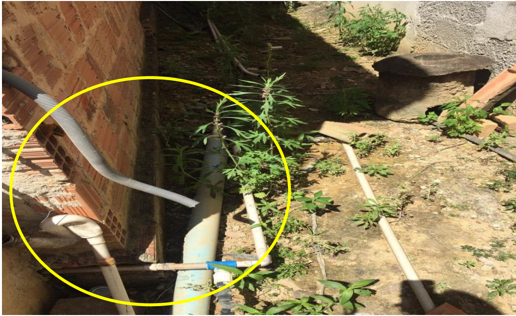
Foto 16: Encanamento de água negra (água servida)
