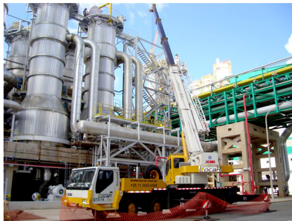
Fig. 13–Guindaste hidráulico sobre caminhão Fonte: (LOCAR, 2008)
