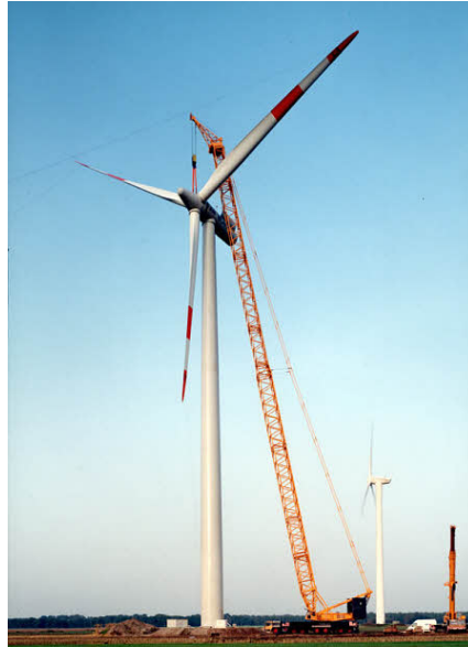
Fig. 4 –Guindaste treliçado sobre caminhão Fonte: (LIEBHERR, 2008)
