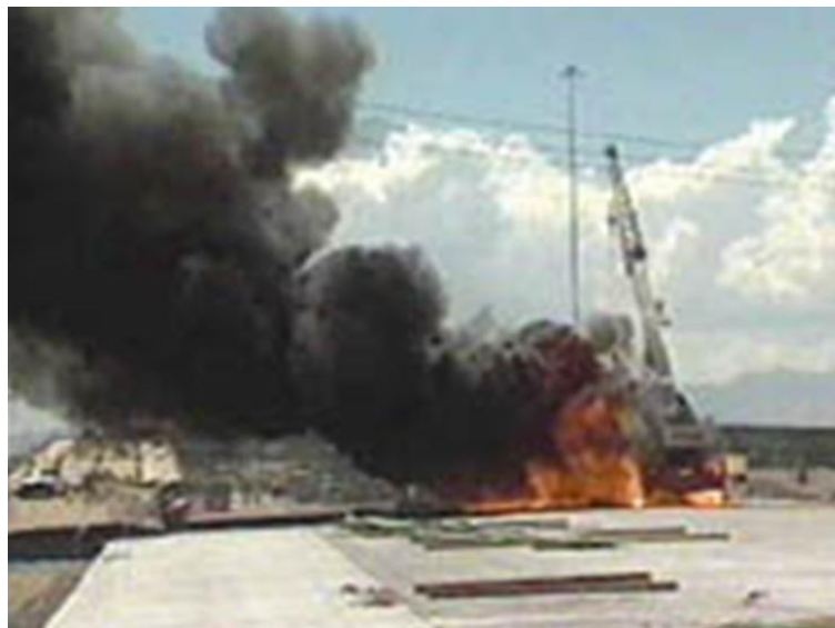
Fig. 83 – Acidente com guindaste na rede elétrica.
