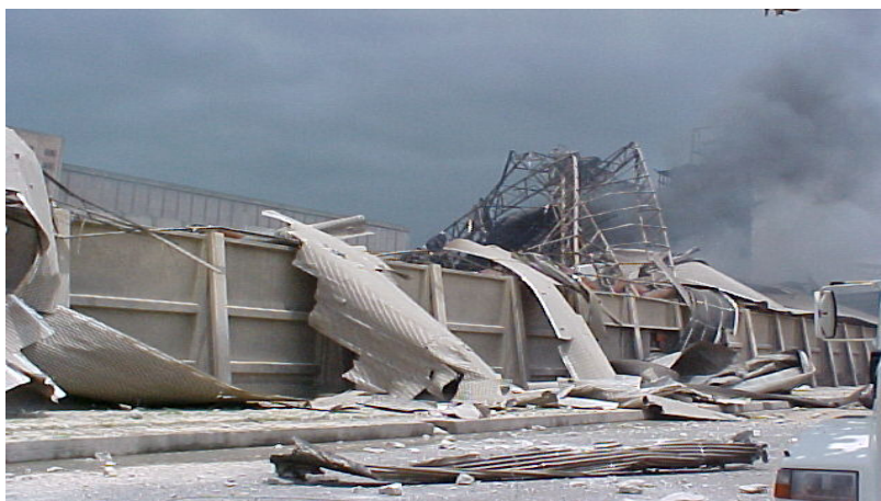
Figura 2 consequências de explosão em silos.
