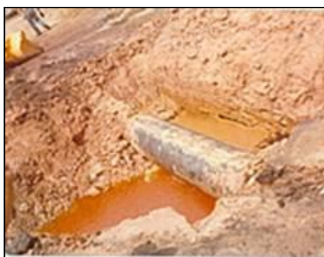
Figura 5 Vazamento de gasolina na Vila Socó
