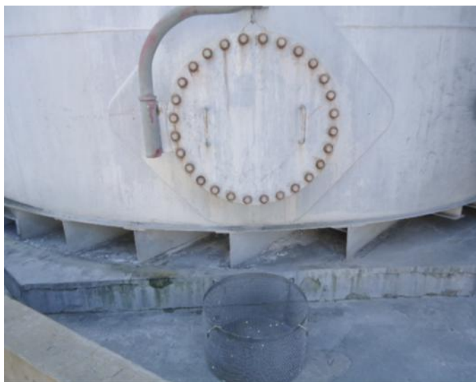
Figura 5: Posição do cesto metálico
