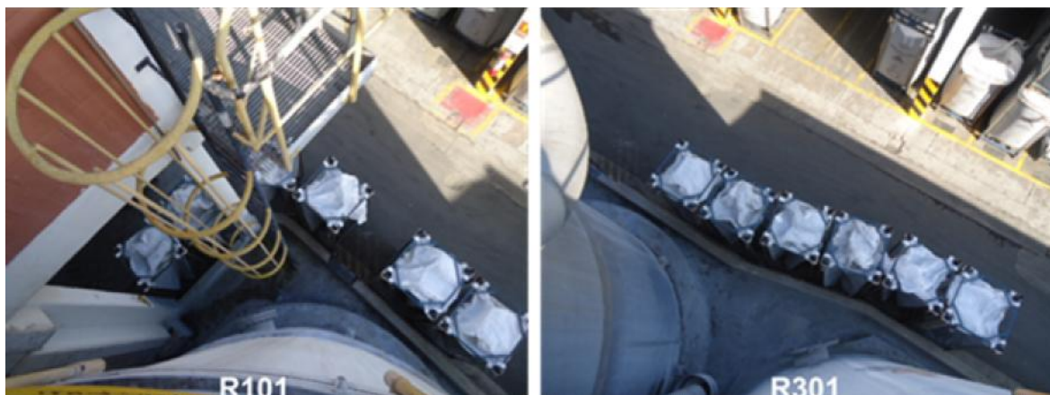
Figura 1: Posicionamento dos big bags ao lado da bacia dos tanques pulmão Fonte: O autor, 2015
