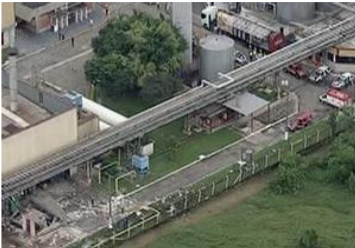
Figura 1 Vista superior do setor de caldeiras após explosão. Fonte: Globo Comunicação e Participações S.A., 2016.
