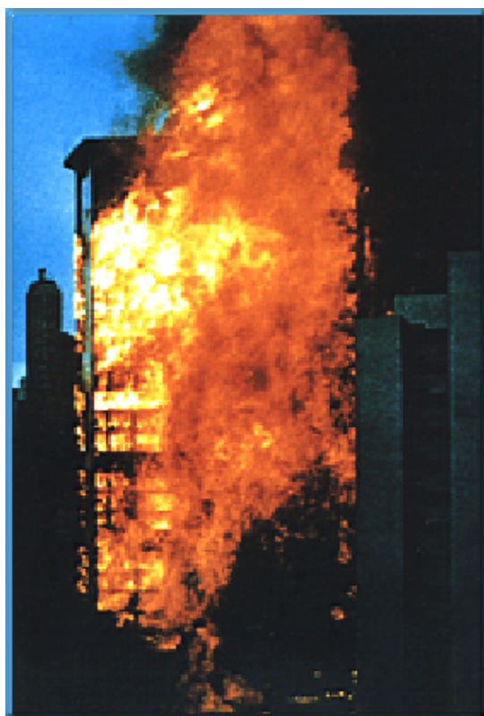
Figura 2 Incêndio do Edifício Andraus (1972)
