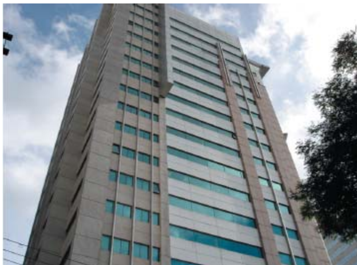
Figura 6 Compartimento vertical de fachada
