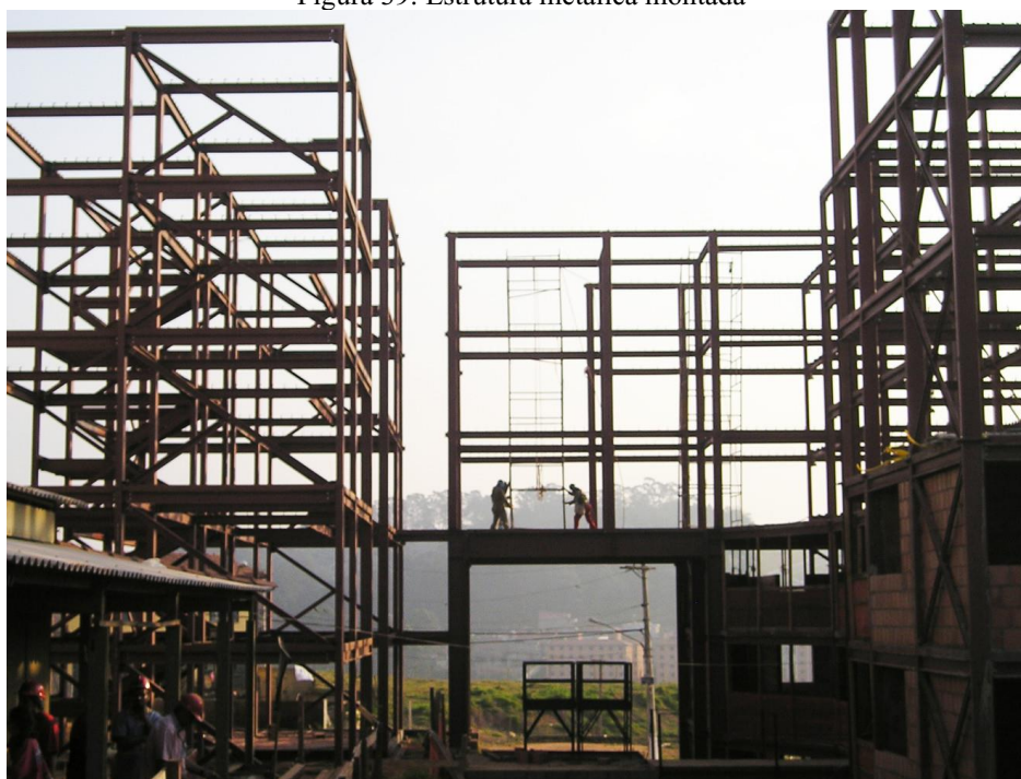
Figura 39: Estrutura metálica montada
