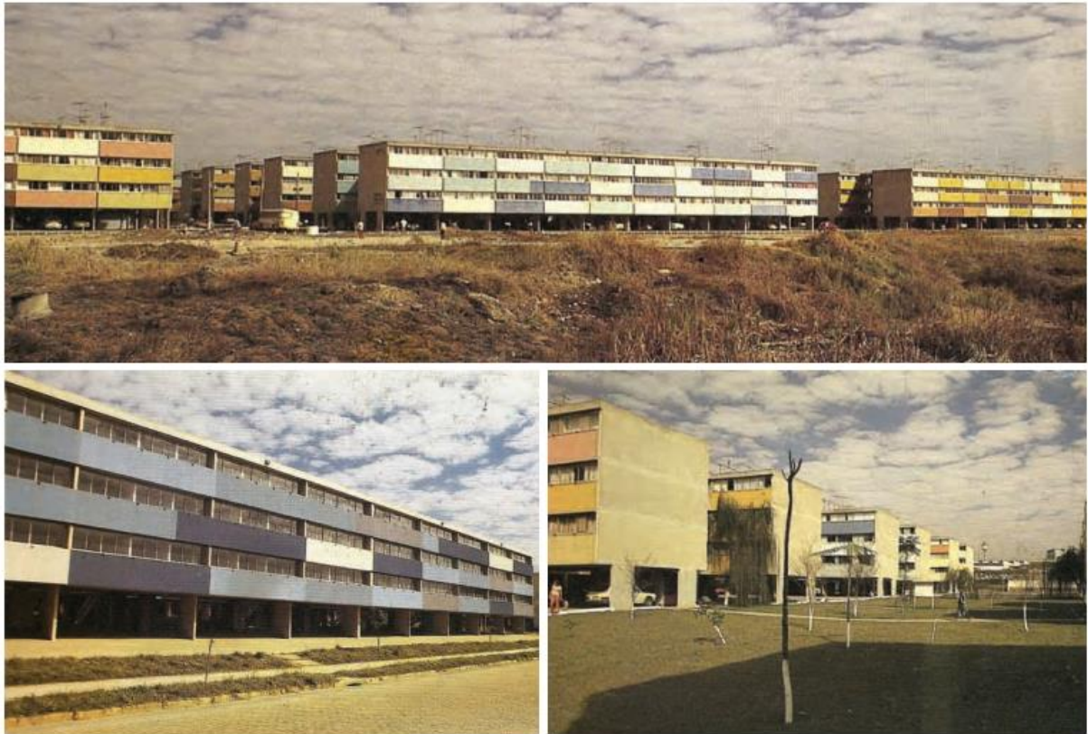
Figura 4: Conjunto habitacional Zezinho Magalhães
