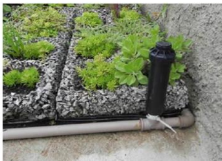
Figura 29 — Ecotelhado Instalado
