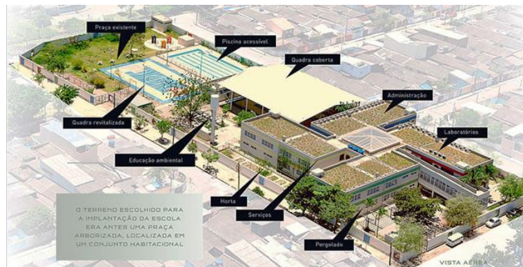
Figura 26 — Vista aérea da implantação da escola Erich Walter Heine
