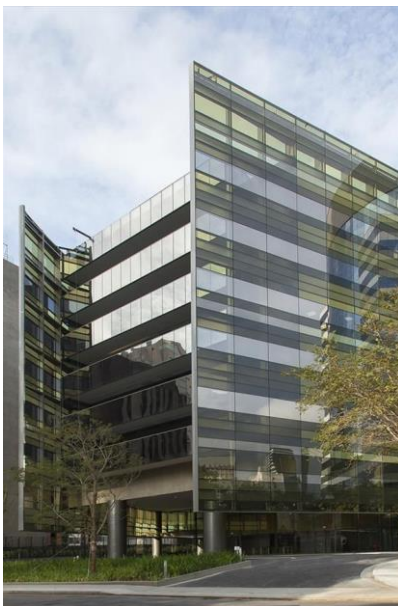
Figura 57 — Fachada vidro de alta performance Edifício Jacarandá
