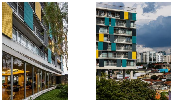
Figura 40 — Fachada Edifício Pop Madalena
