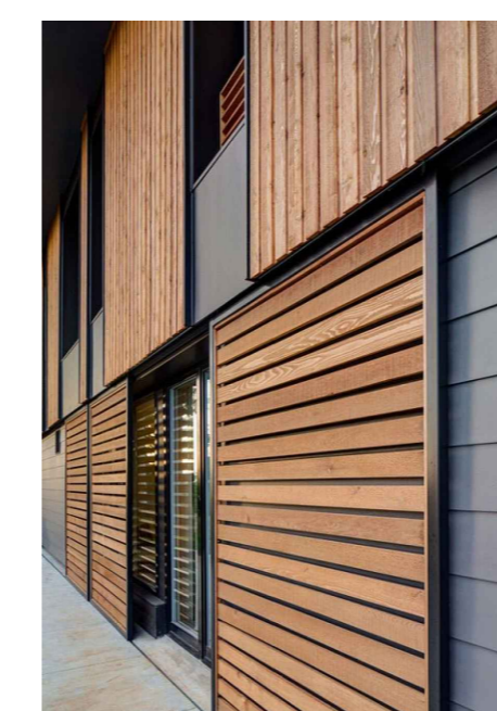
O Modelo de brises móveis deslizantes usados no projeto, material de alumínio com textura de madeira.
