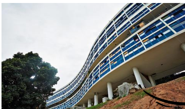
Figura 6 - Conjunto Residencial Pedregulho - Rio de Janeiro
