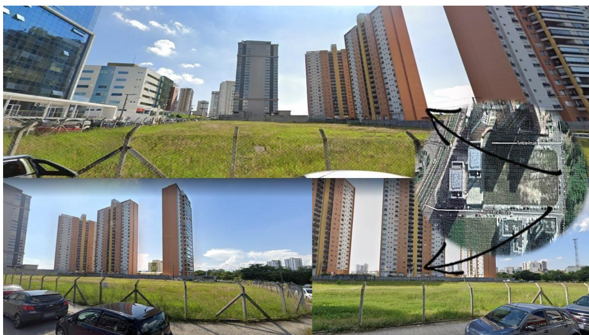
Figura 66 - Fotos do Terreno
