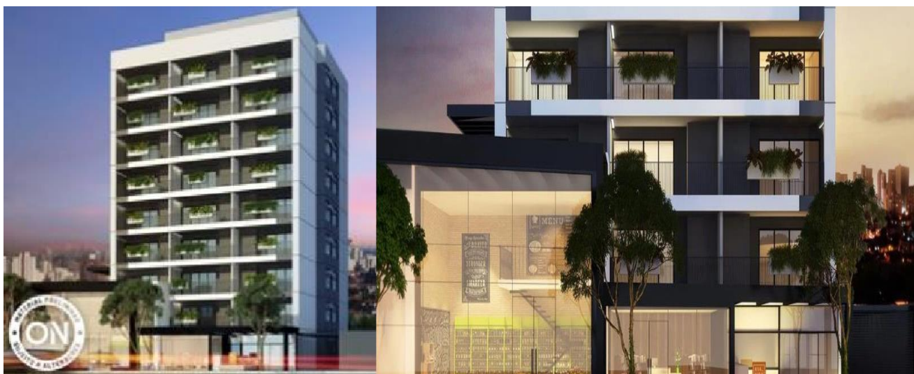
Figura 50 - Fachada Coliving NV
