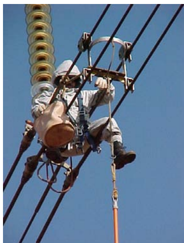
Figura 9 - Recebimento e instalação da bicicleta pelo eletricista C Fonte: CTEEP, 2001
