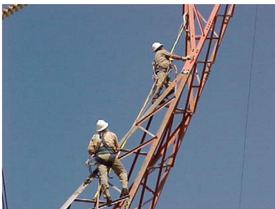
Figura 3 - Escalada dos eletricitistas A e B, levando a corda de segurança e corda de serviço Fonte: CTEEP, 2001
