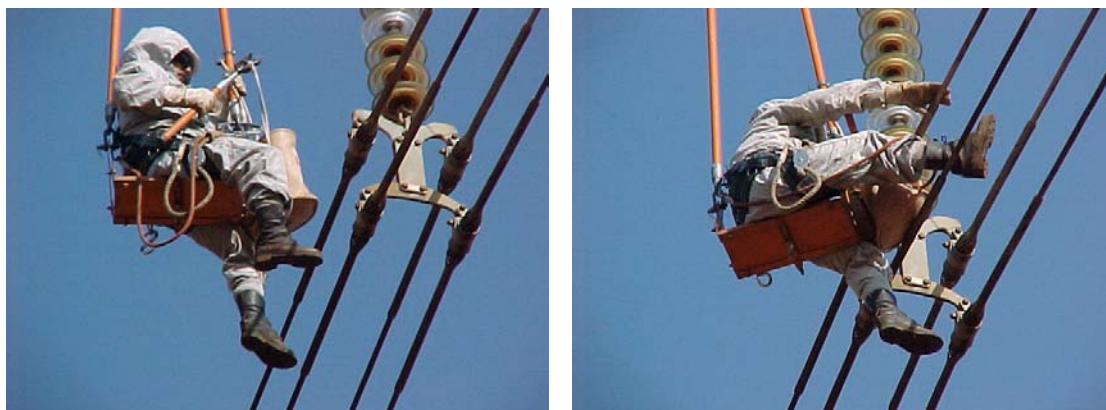
Figura 7 - Detalhe da entrada do eletrícista C equalizando o potencial e subindo sobre os cabos da fase lateral Fonte: CTEEP, 2001
