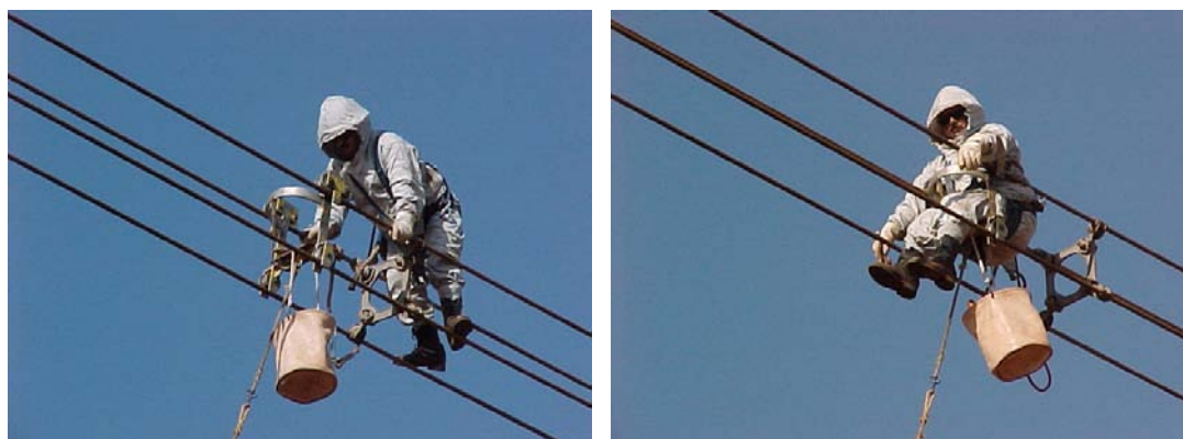
Figura 13 - Passagem do eletrcista C sobre o espaçador Fonte: CTEEP, 2001
