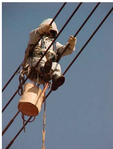
Figura 10 - Deslocamento do eletricitista C sobre os cabos condutores Fonte: CTEEP, 2001
