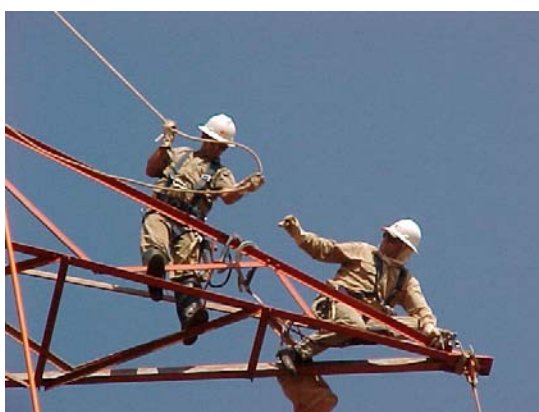
Figura 6 - Eletricitistas A e B executando o rabicho para saída na fase lateral ou central Fonte: CTEEP, 2001
