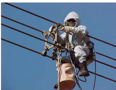
Figura 11 - Posição de trabalho para troca do espaçador Fonte: CTEEP, 2001
