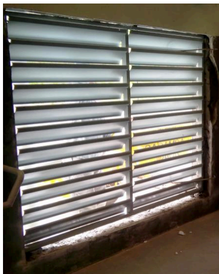
Figura 19: Janelas para melhorar a circulação de ar Fonte: elaborado pelo autor
