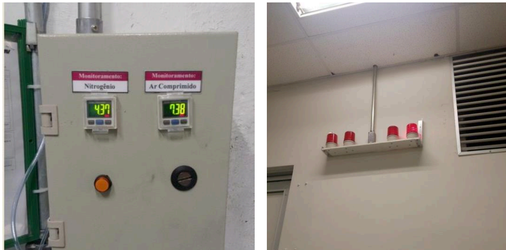
Figura 24: Sistema de alerta de queda de pressão
