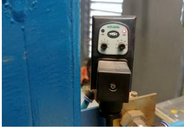
Figura 15: Timer eletrônico do dreno automático Fonte: elaborado pelo autor
