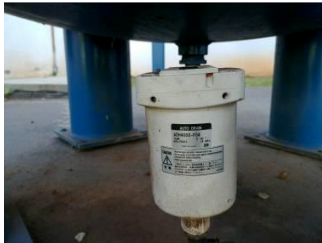
Figura 14: Dreno automático na base do pulmão
