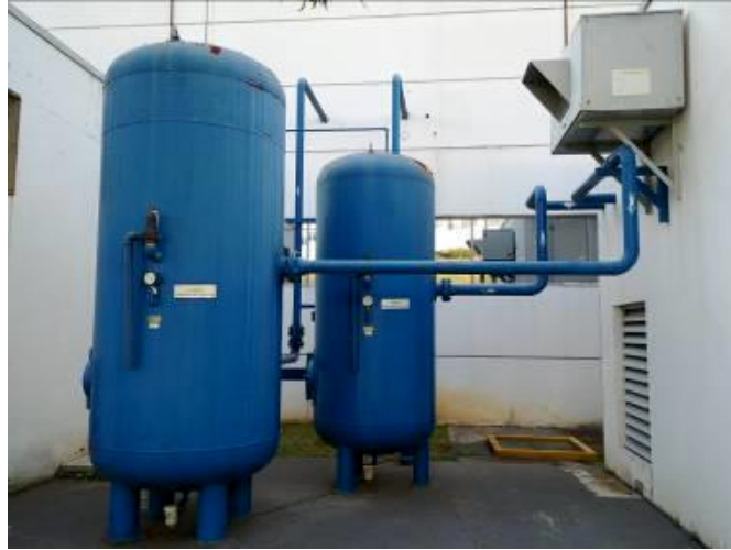
Figura 13: Pulmão de ar e ramais de distribuição
