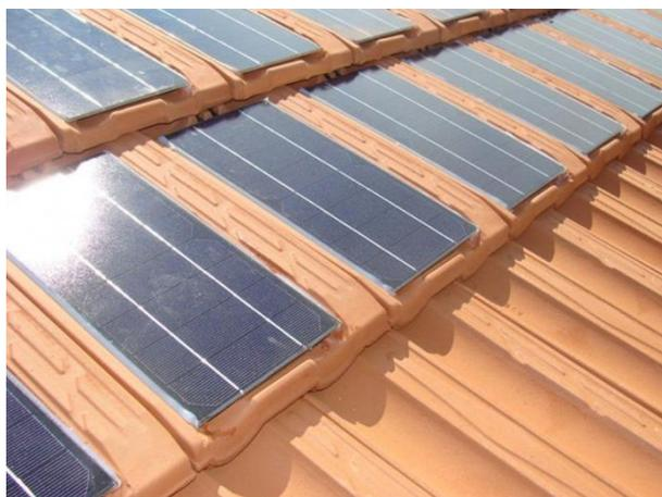
Figura 107- Telhas solares.
