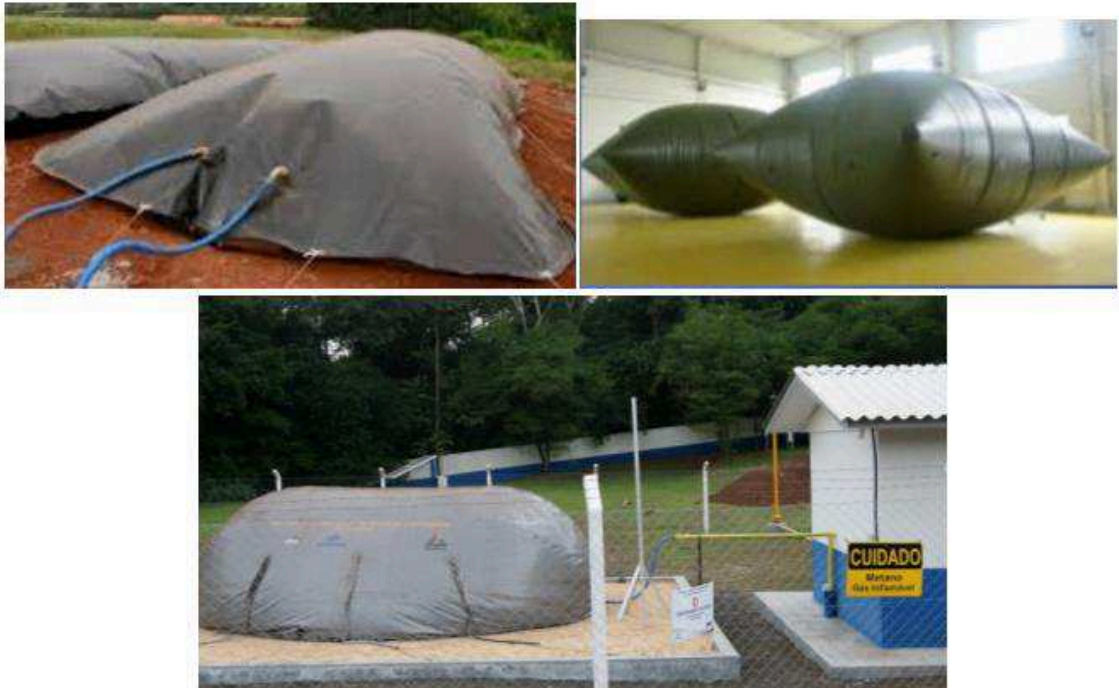
Figura 9 – Vistas de gasômetro tipo balão / travesseiro Fonte: Godoy Junior e Jesus (2015)
