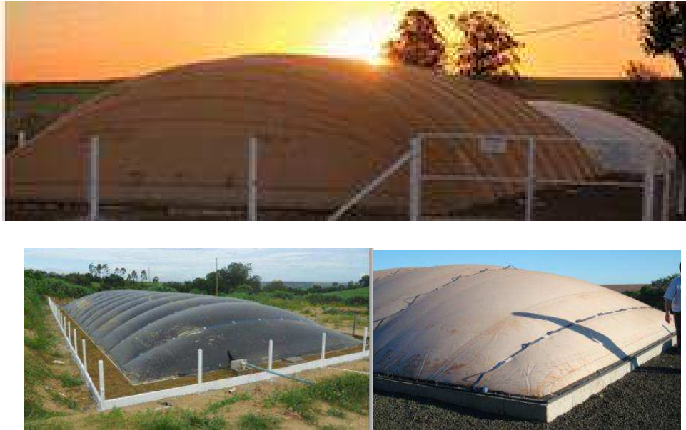
Figura 10 – Vistas de gasômetro tipo cúpula ou campânula flexível de lagoa coberta Fonte: Godoy Junior e Jesus (2015)
