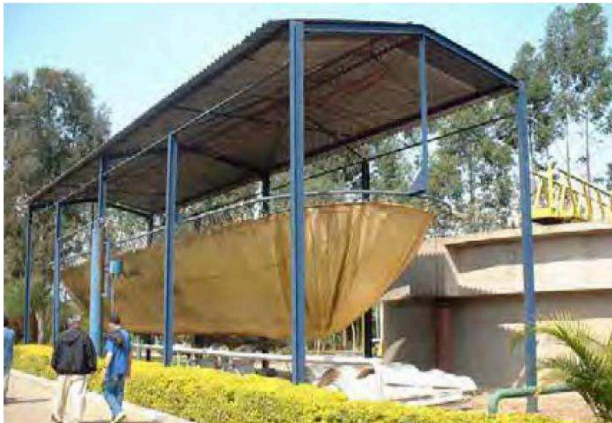
Figura 8 - Gasômetro do tipo Zeppelin, fora de operação por motivos de segurança Fonte: Godoy Junior (2010)
