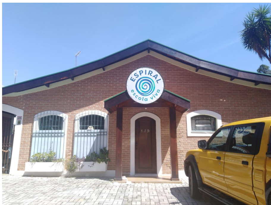
Figura 33 - Fachada da Escola Espiral.
