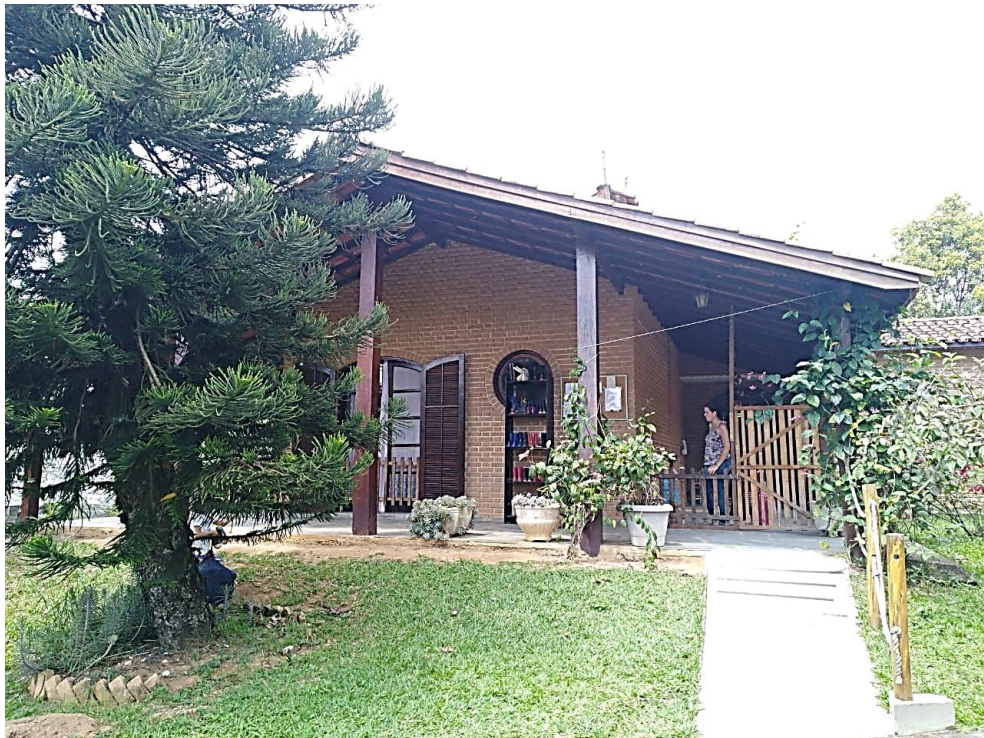
Figura 45 - Fachada da Quintal da Mantiqueira.
