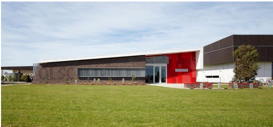
Figura 12 - Fachada da Escola Básica Nossa Senhora da Cruz do Sul.
