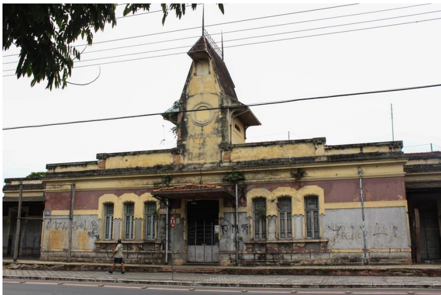
Figura 46 - Degradação da Estação Ferroviária, na R. Dino Bueno.
