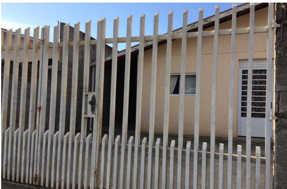
Figura 58: Fachada modificada com a implementação do portão
