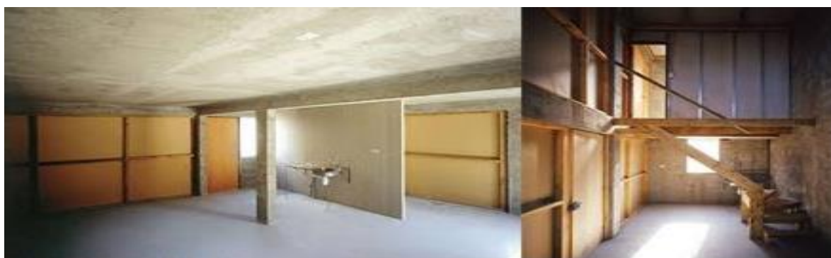
Figura 17: Acabamento interno - Fonte: LWarq.
