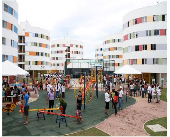
Figura 23: Área de lazer do Conjunto Habitacional de Heliópolis - Fonte: Ruy Ohtake.
