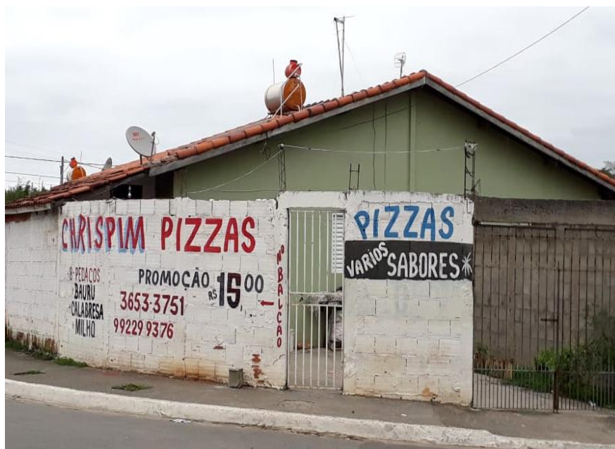
Figura 63: fachada modificada pela presença de muro e portão
