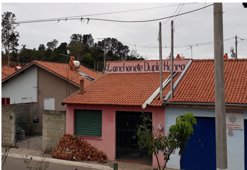
Figura 60: Alteração na fachada para uso comercial, implementação de cobertura, janela e portão
