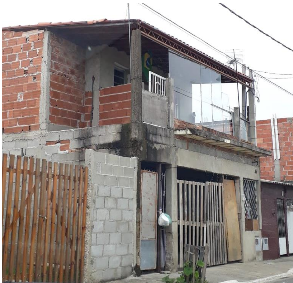
Figura 64: Ampliação de residência por meio da construção de um segundo pavimento, alteração na planta
