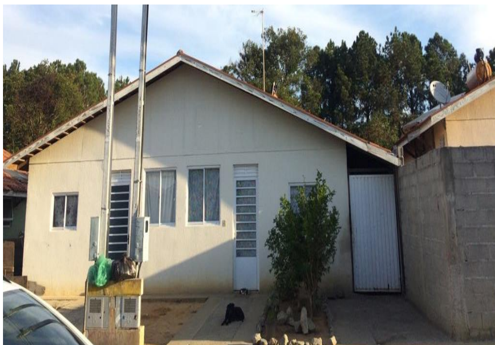
Figura 59: Implementação de um portão lateral, sem alteração na fachada
