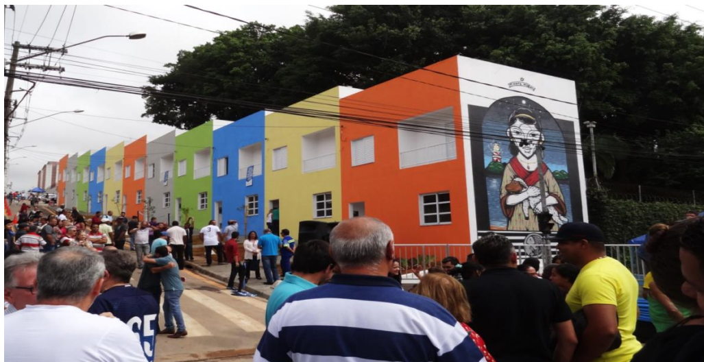
Figura 9: Inauguração feita em 27 de janeiro de 2018, depois de 5 anos de obras - Fonte: CAU/BR (Foto: Mauro Pedroso).
