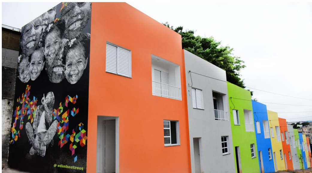
Figura 10: Fachadas e Mural das Casas Cubo, 2018. - Fonte: CAU/BR.
