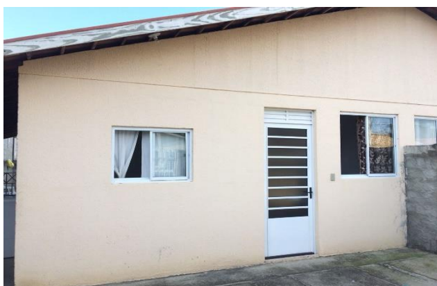
Figura 33: Fachada do conjunto habitacional - Fonte: Autora, 2018.
