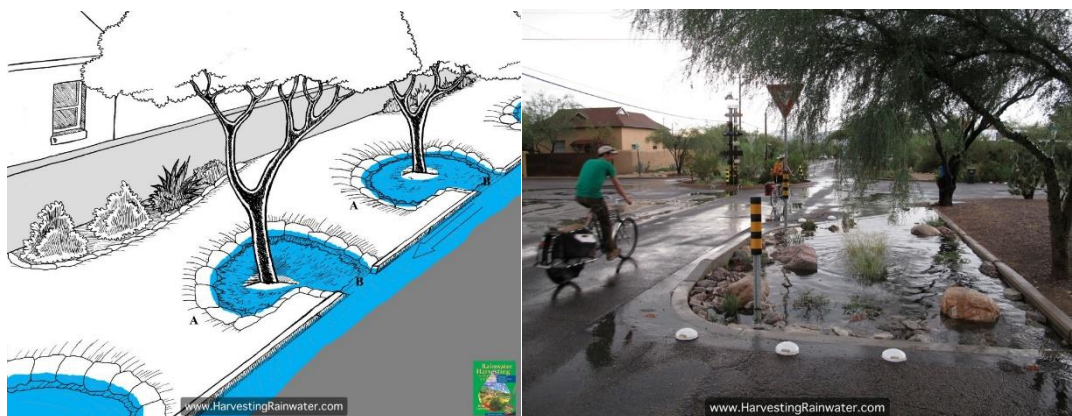
Figura 2 - Jardins de chuva em calçadas / Jardim aplicado em uma esquina
