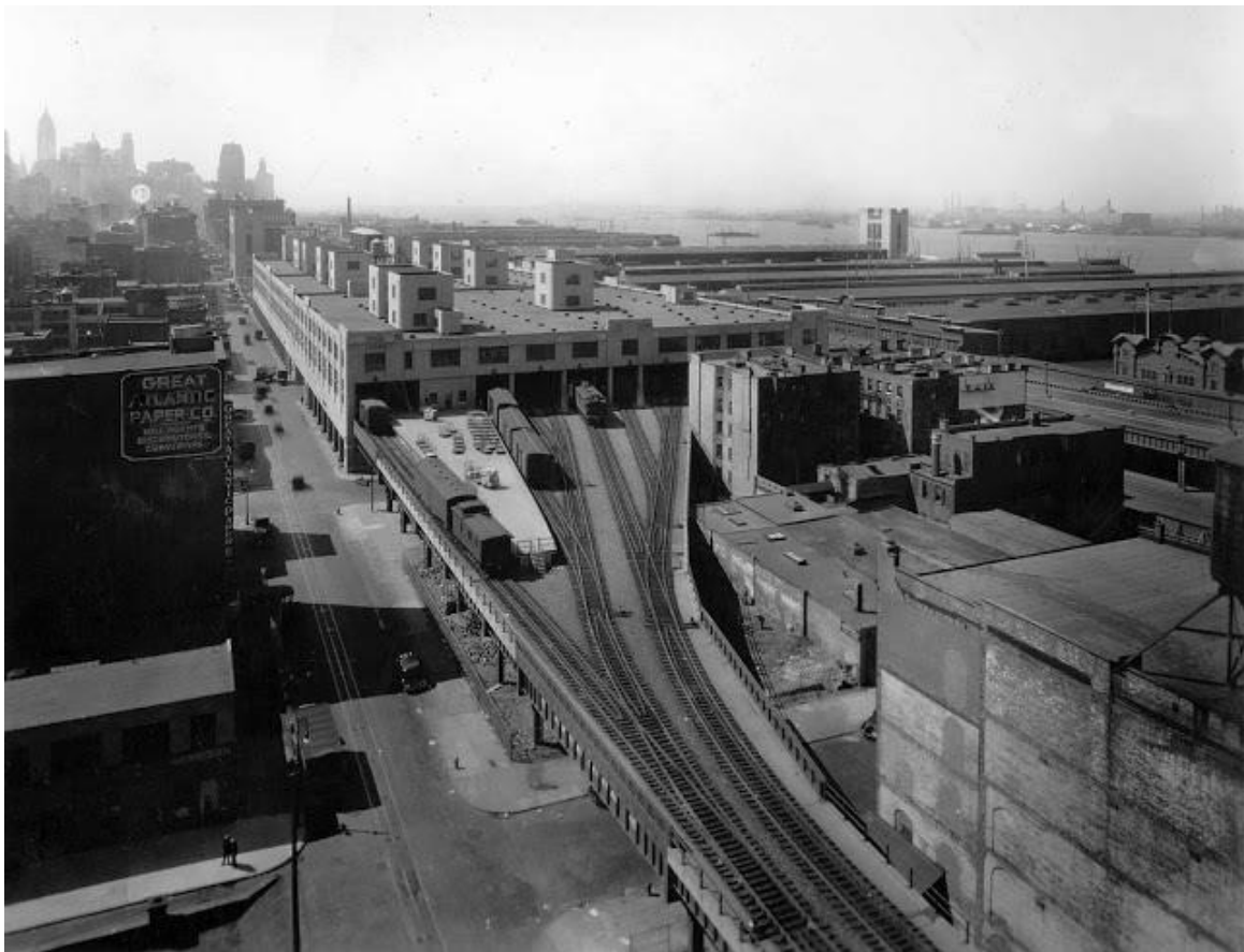
Figura 22 - Espaço com a linha de trem antes do projeto de revitalização do Parque High Line
