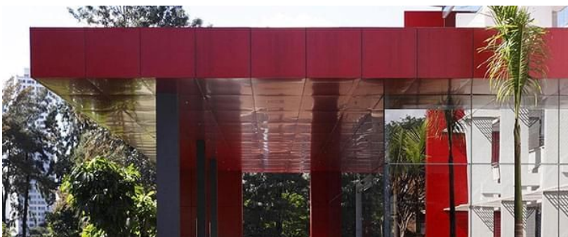
Figura 59 - Exemplo do uso do painel de acm em fachada externa.
