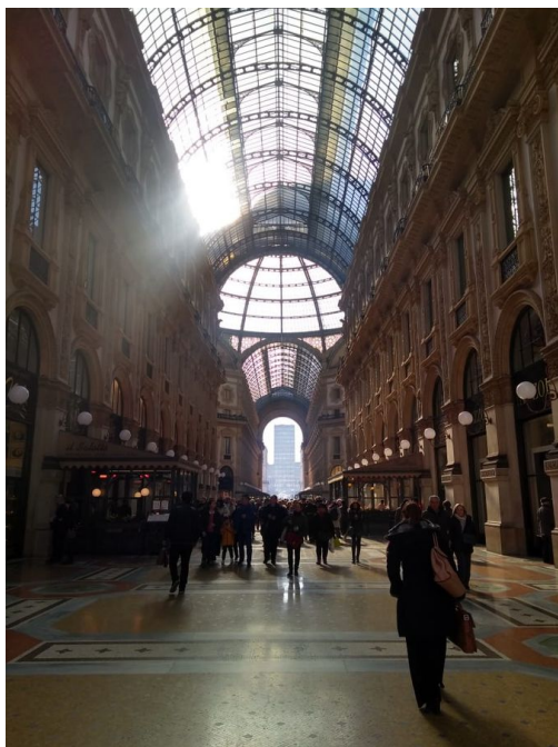
Figura 29 - Cobertura de vidro da galeria
