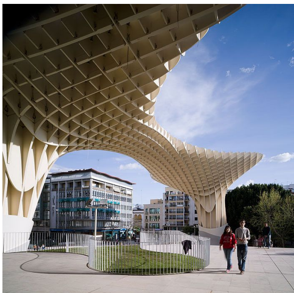
Figura 5 - Vista da cobertura a partir da altura do observador
