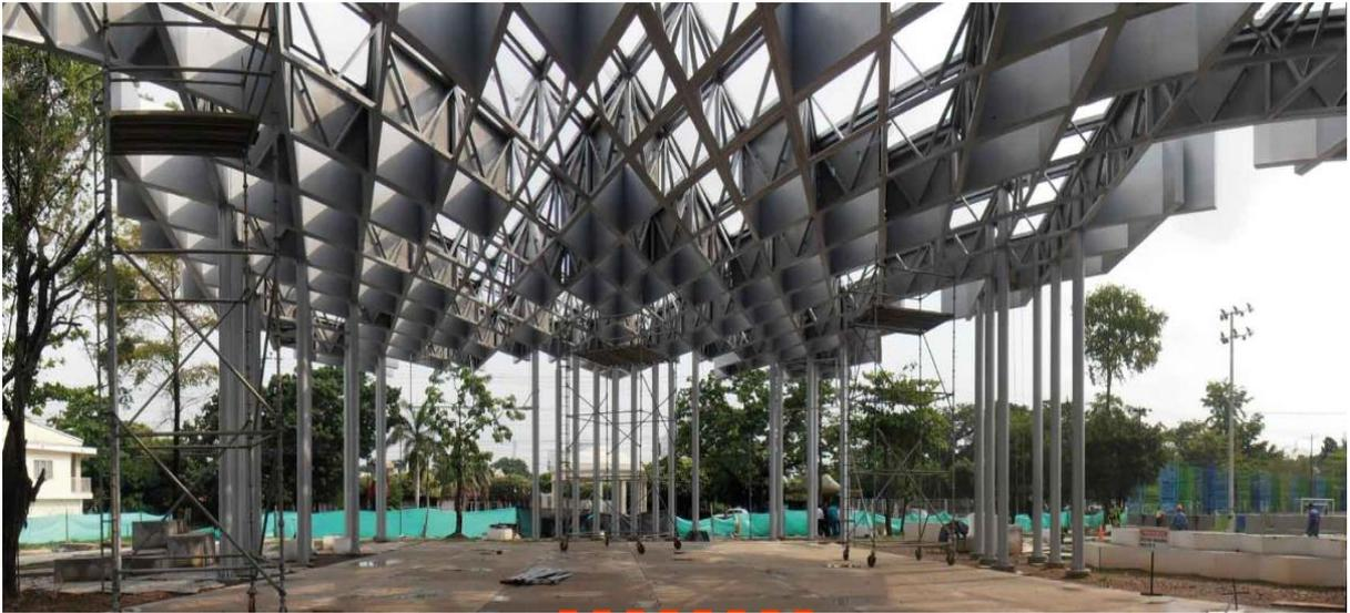
Figura 30 – Estrutura metálica da cobertura
